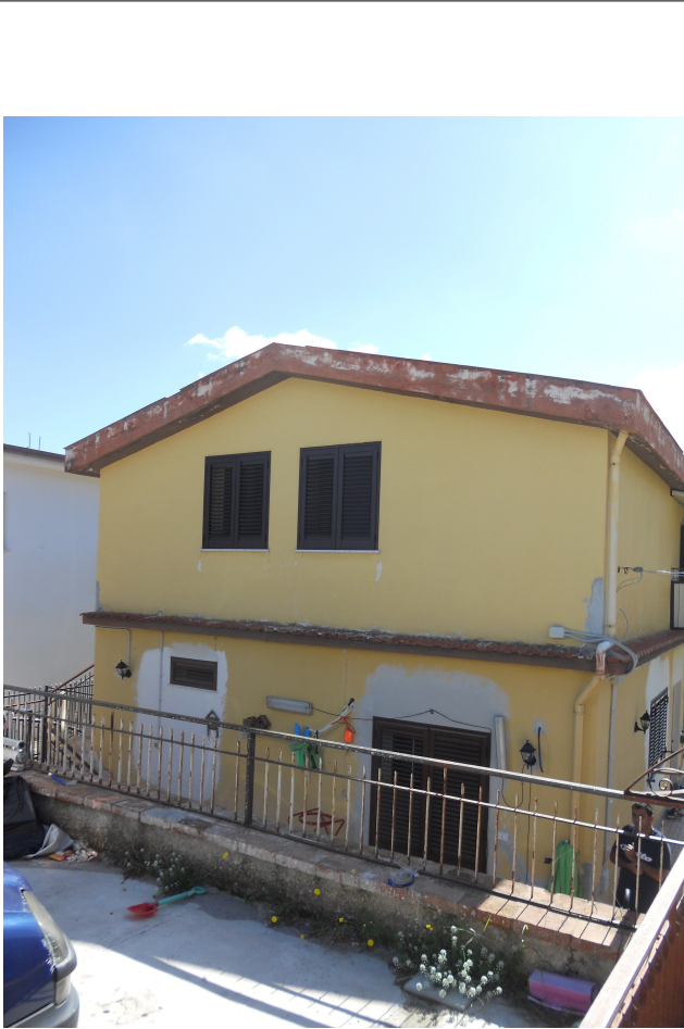
Prospetto su strada del fabbricato
