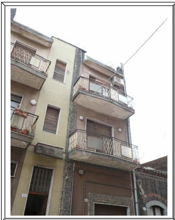
PARTICOLARE PROSPETTO EDIFICIO
