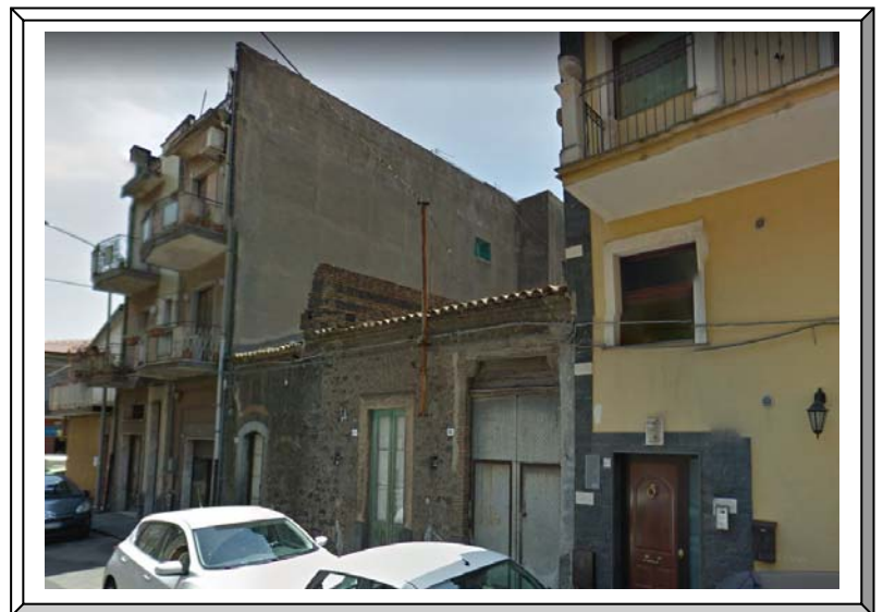
PARTICOLARE PROSPETTO EDIFICIO
