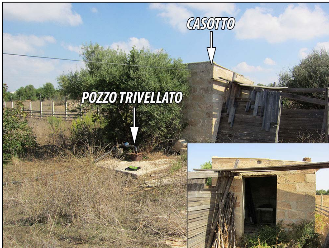
Foto-9 (Casotto al servizio del pozzo, nel riquadro vista dell'ingresso)
