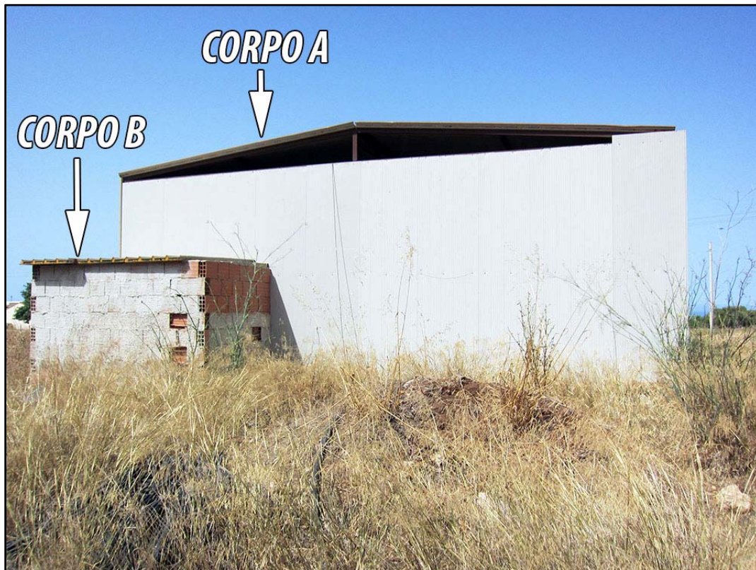
Foto-3 (Struttura non regolarizzata, prospetto Est)
