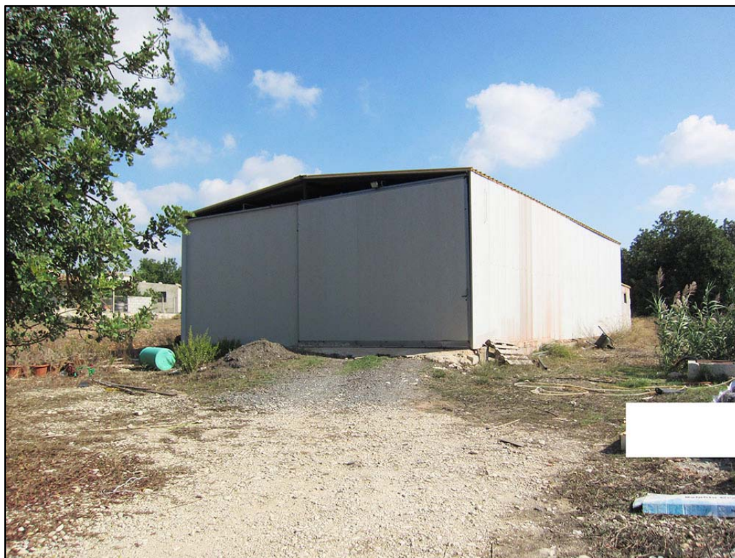
Foto-2 (Struttura non regolarizzata, prospetto Ovest)
