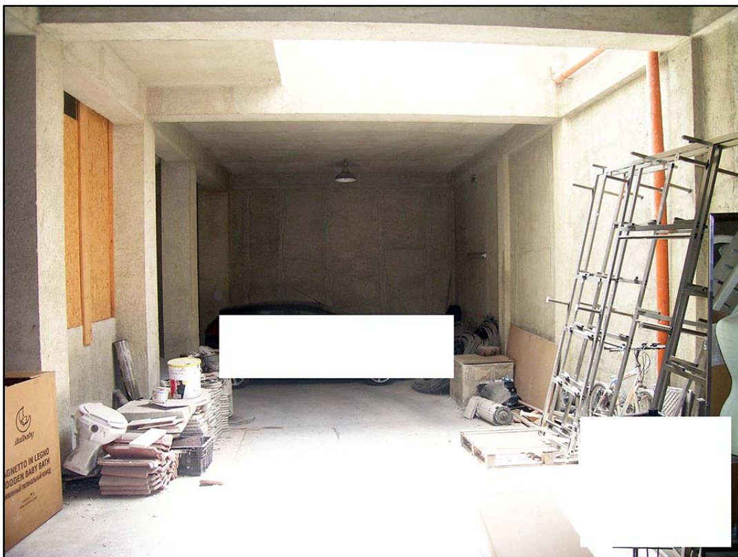
Foto-8 (Garage, con in alto il pozzo di luce)
