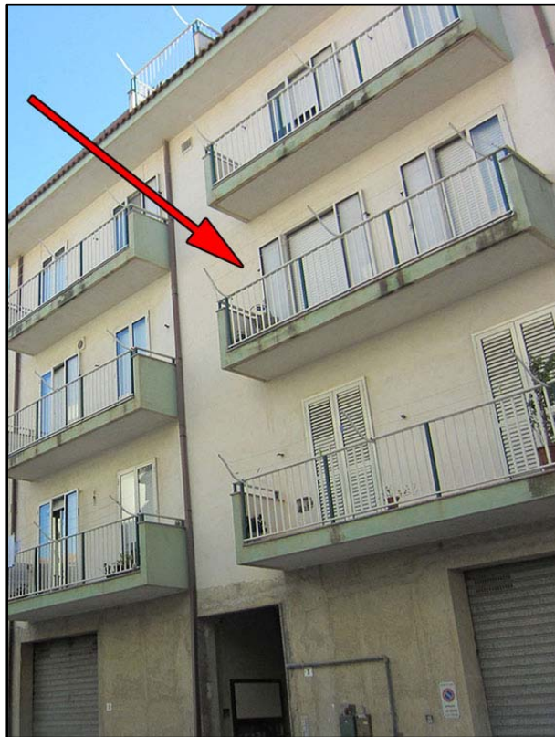
Foto-1 (Prospetto principale)
