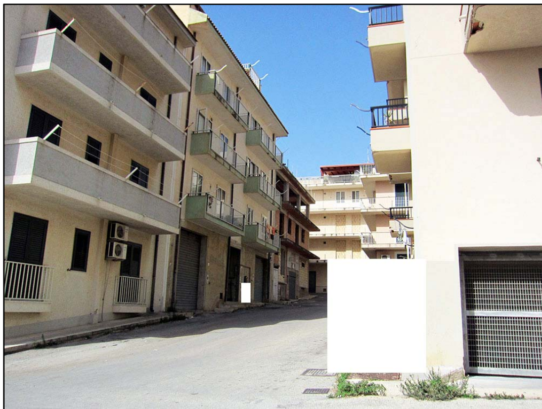
Foto-2 (Prospetto principale)
