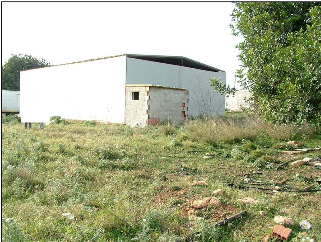
Foto-4 (terreno circostante la struttura non regolarizzata)
