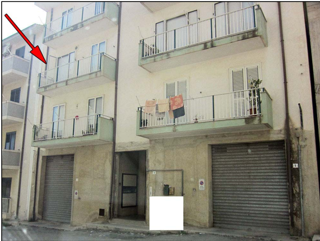
Foto-1 (Prospetto principale)
