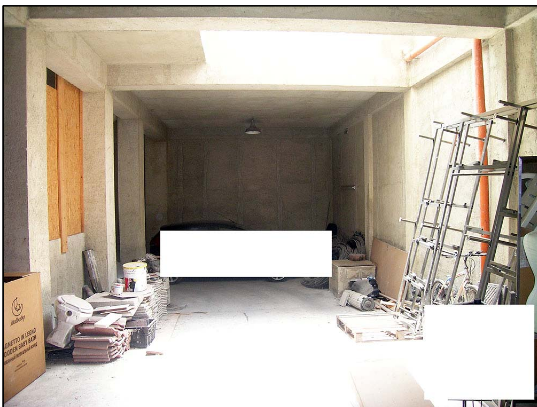
Foto-8 (Garage, con in alto il pozzo di luce)
