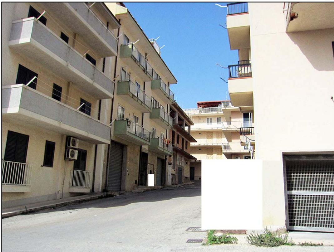
Foto-2 (Prospetto principale)
