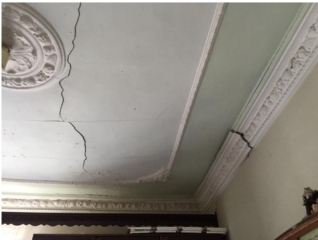
Foto n. 16 – Soggiorno/pranzo: stato di dissesto del soffitto
