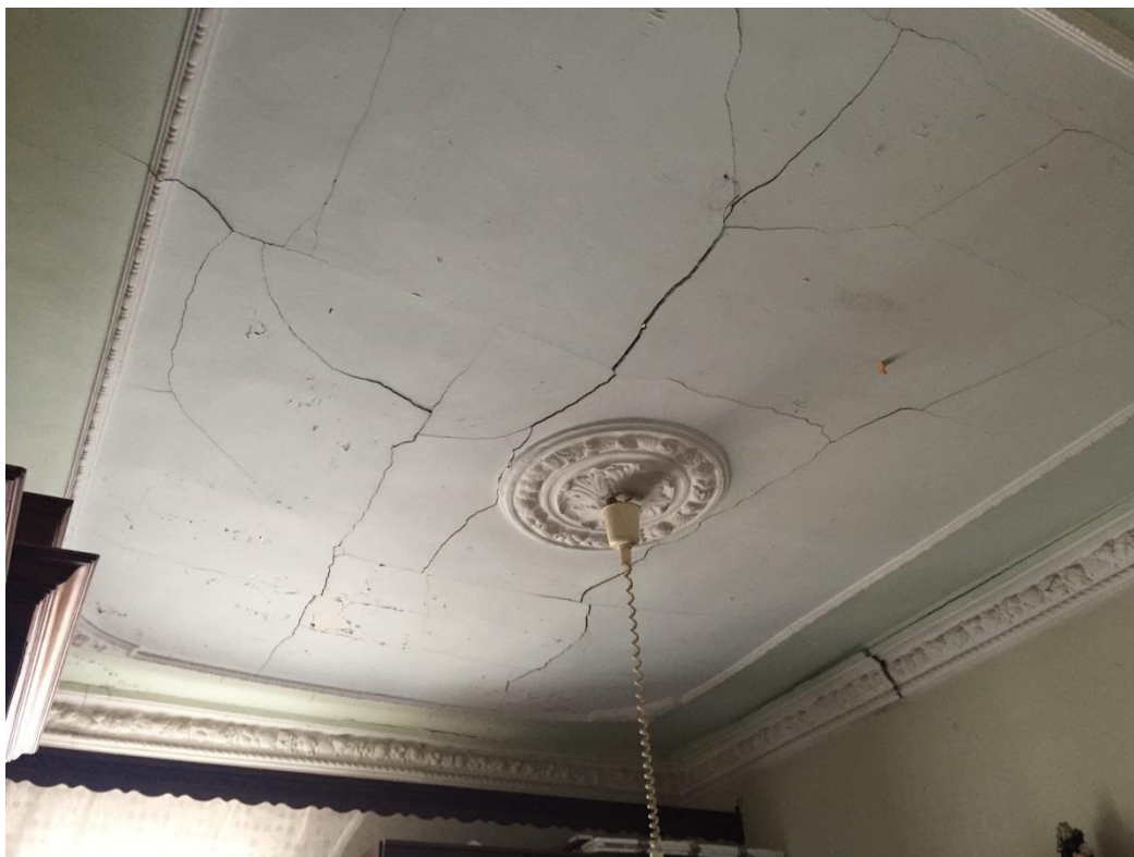
Foto n. 15 – Soggiorno/pranzo: stato di dissesto del soffitto
