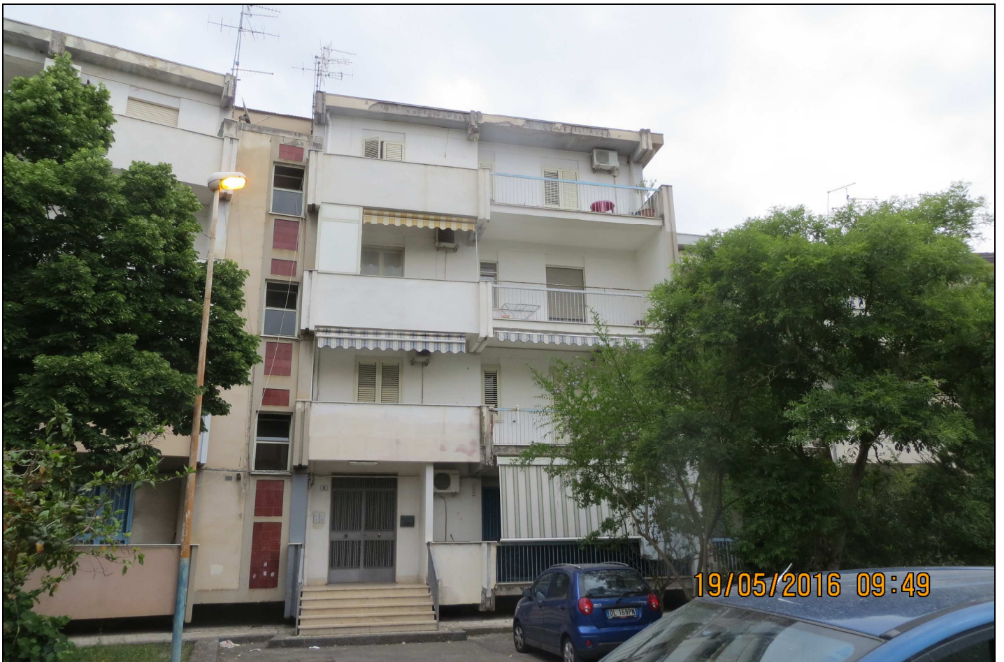
FOTO 16 (PROSPETTO SU LARGO PIRA)
