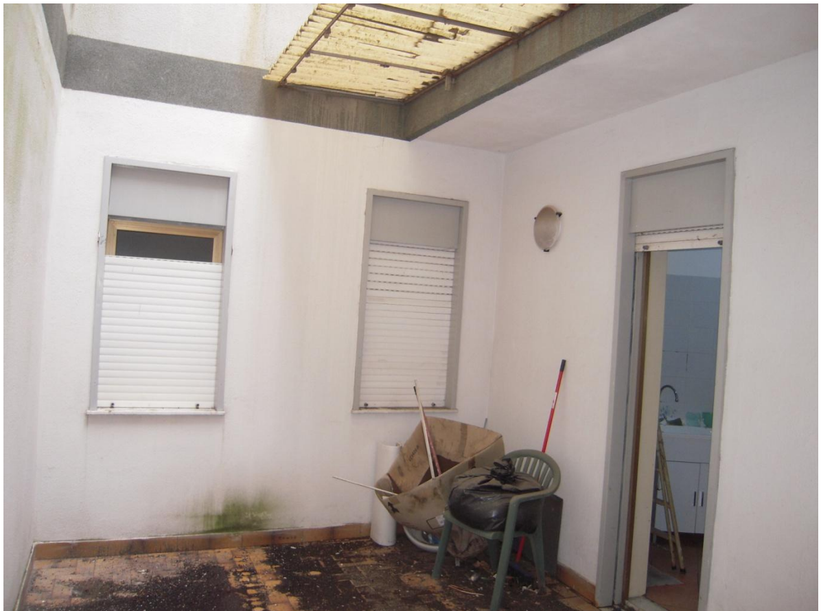
CHIOSTRINA INTERNA- FINESTRE CORRIDOIO BAGNO- PORTA LAVANDERIA
