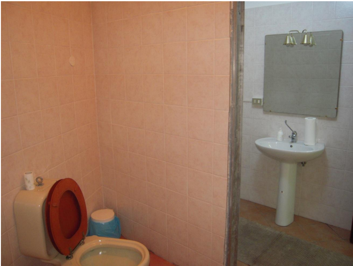
BAGNO CON ANTIBAGNO
