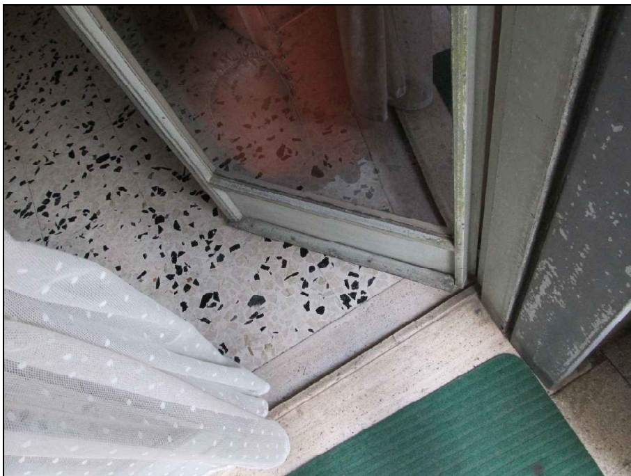
FO - 22 - Balcone Interno
