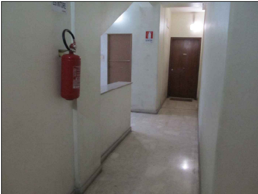
FO - 10 - Vano Scala Condominio
