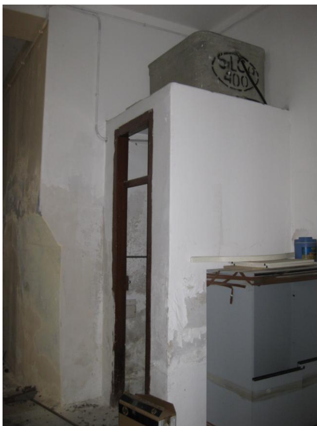
Foto 8: Il servizio w.c.; in alto il sistema di raccolta idrica
