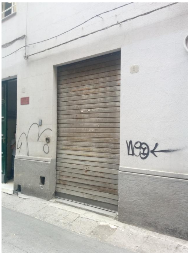
Foto 5: La serranda metallica avvolgibile d'ingresso al magazzino
