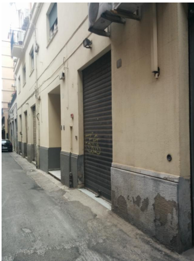
Foto 5: La serranda metallica avvolgibile d'ingresso al magazzino
