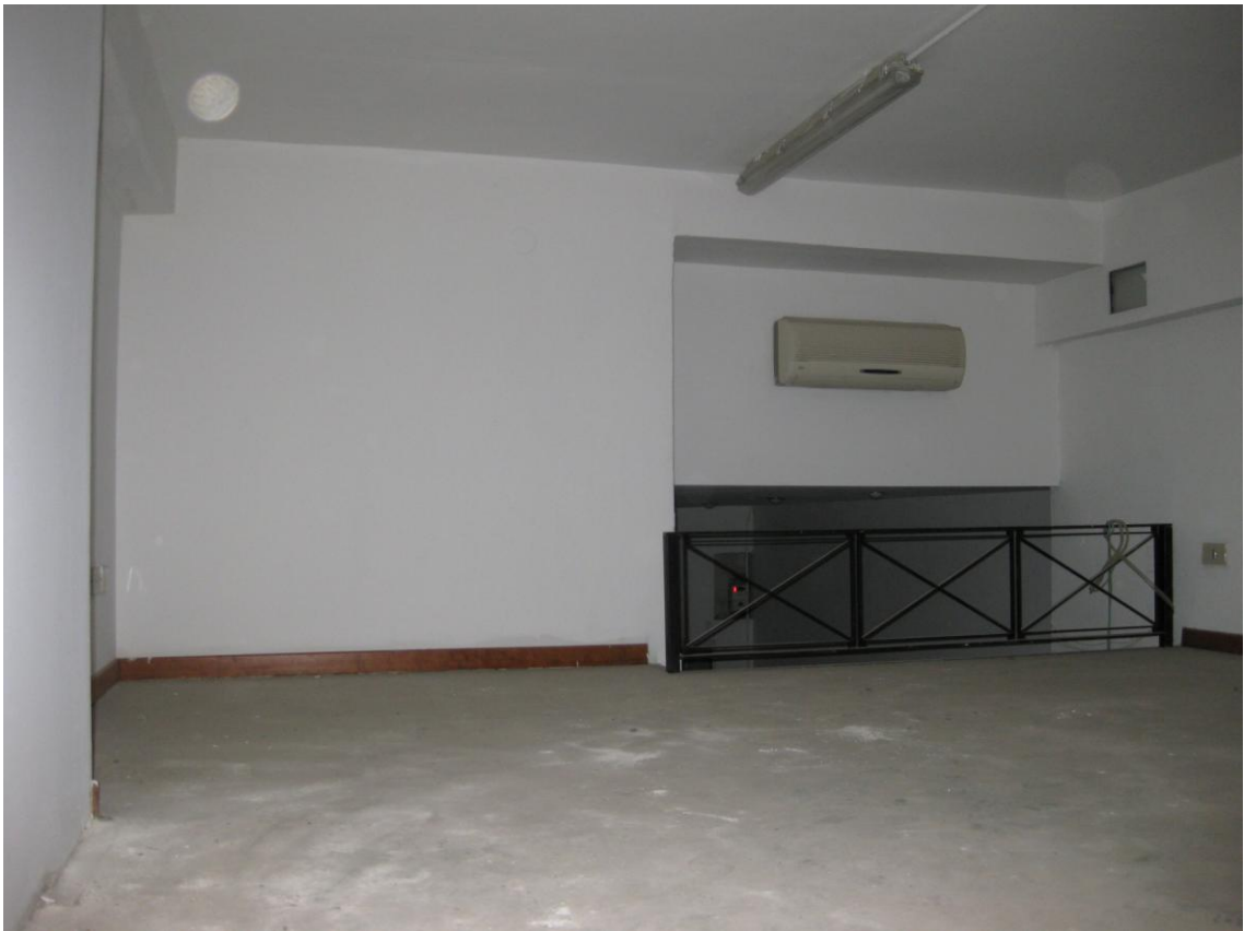
Foto 9: Il soppalco, realizzato con struttura in acciaio e tavolato ligneo
