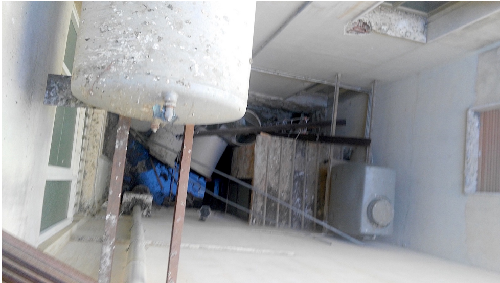
Foto 13 Cavedio comune, sub 10
