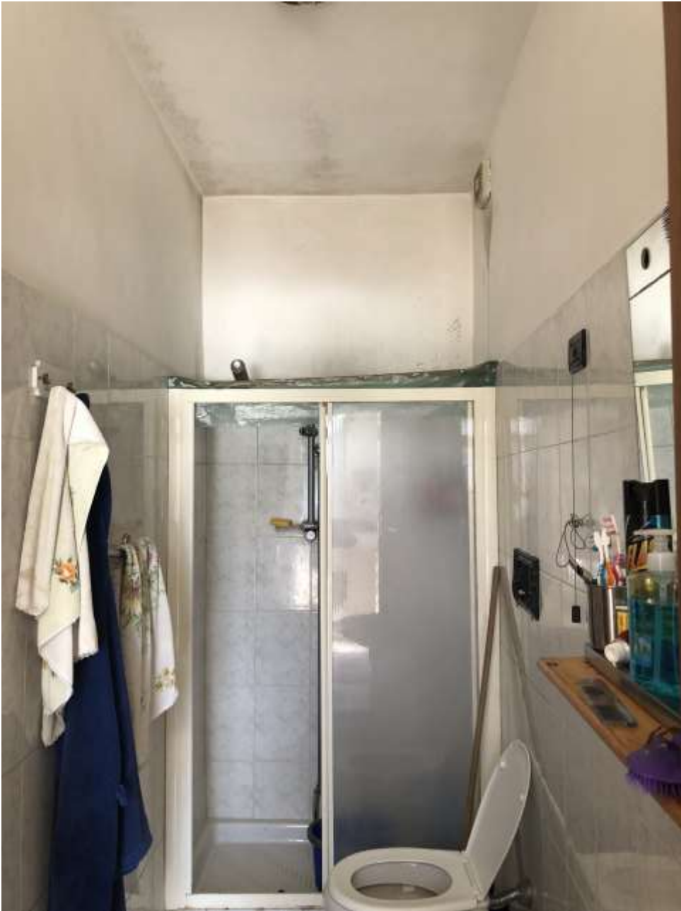
Foto 24: bagno al piano terra
