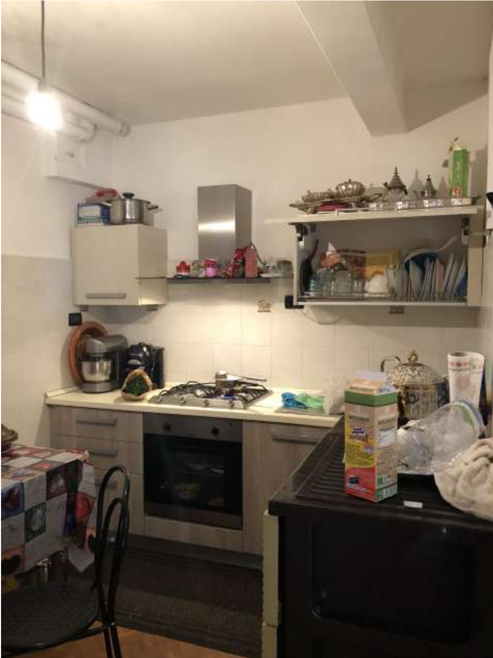
Foto 16: immagine della cucina con controsoffitto in cartongesso
