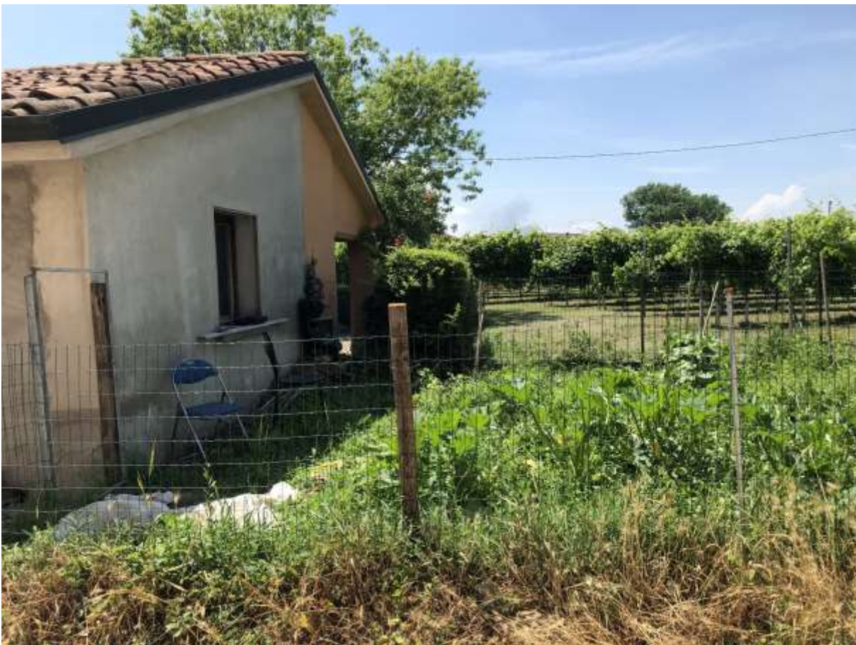
Foto 41 e 42: foto esterne del fabbricato destinato a rustico
