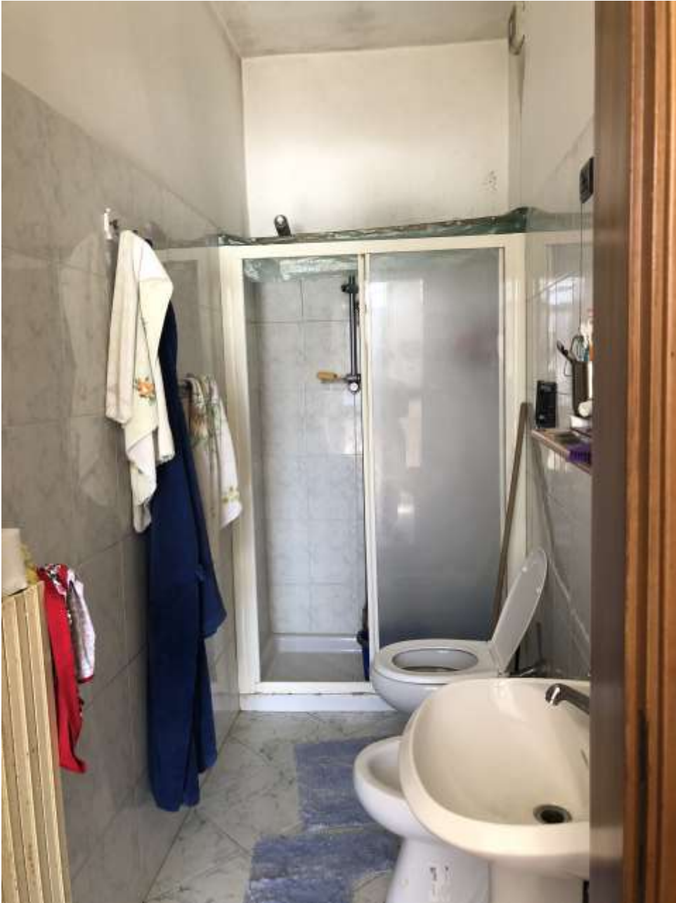
Foto 22: bagno al piano terra con doccia
