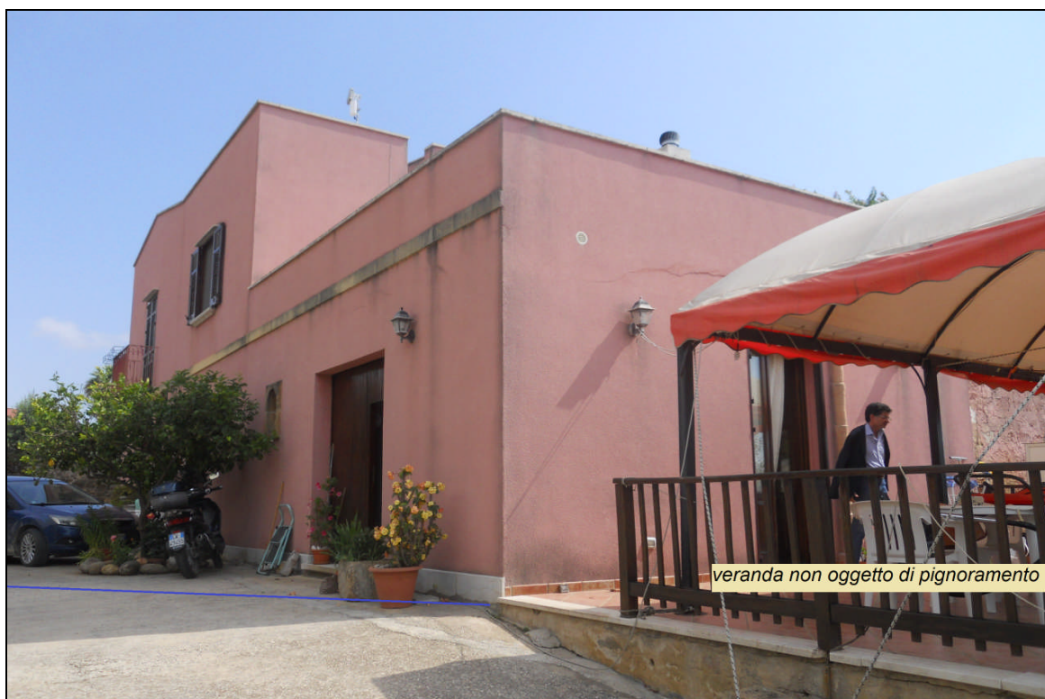
Figura 2: prospetto principale lato est fabbricato con corte pertinenziale - via Verderame 35, Paceco.
