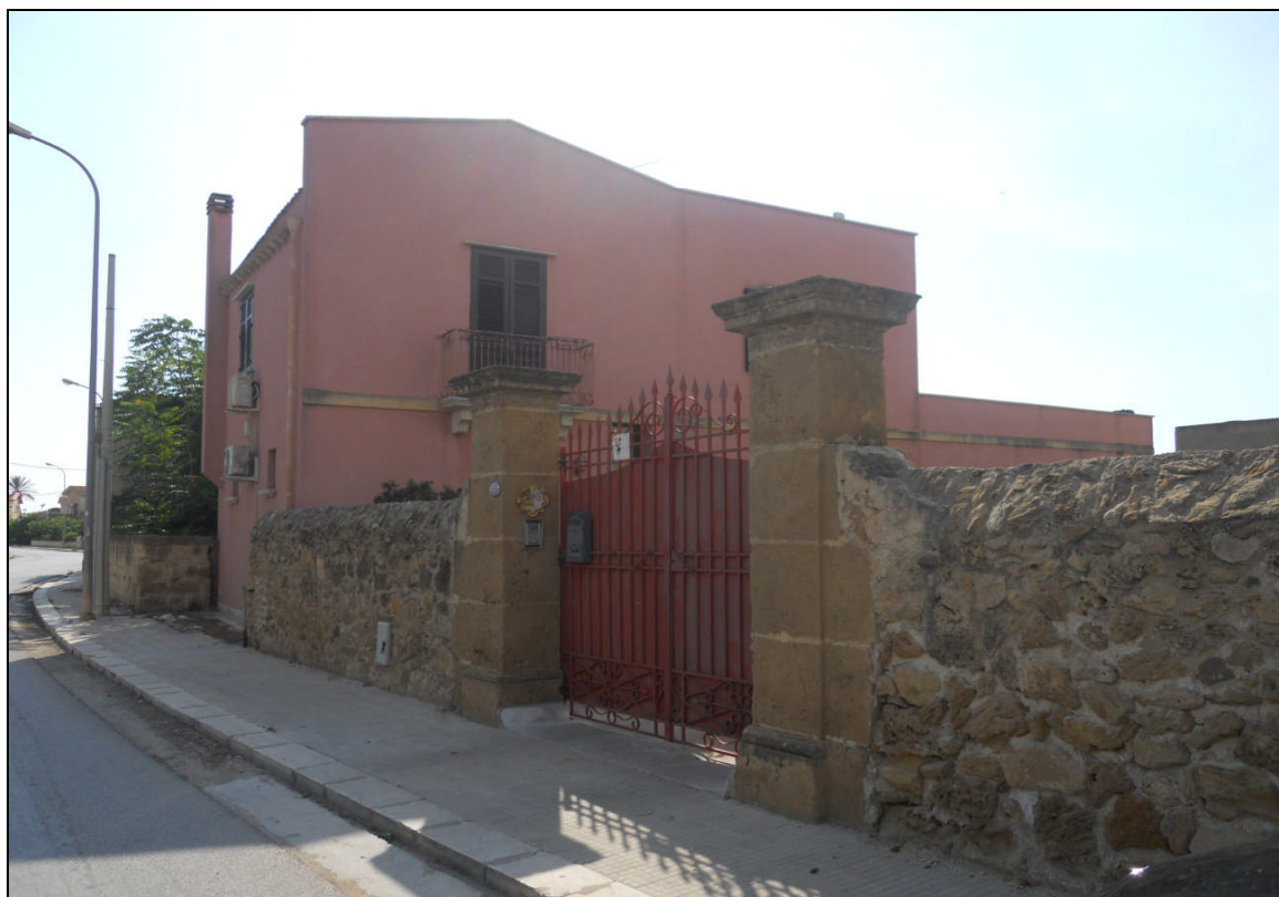
Figura 1: panoramica generale fabbricato urbano - via Verderame n. 35, Paceco.
