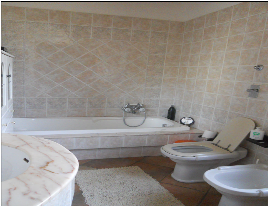
Figura 9: particolare vano bagno - piano primo.
