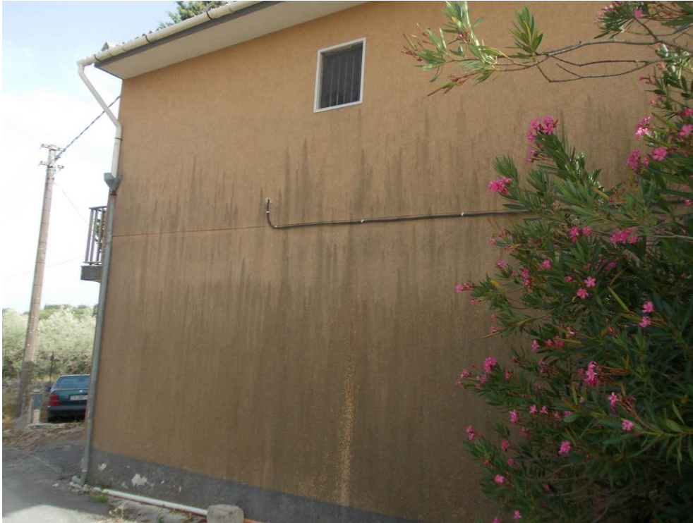
Foto 2 (prospetto su via Vanella 180)
