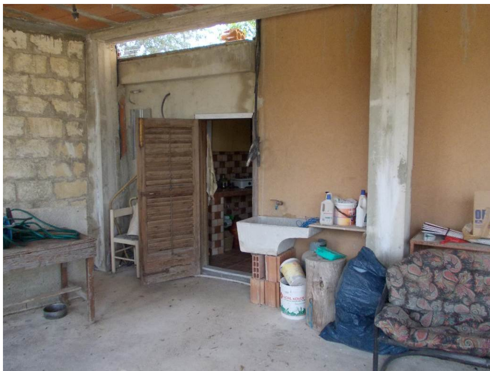
Foto 10 (vista della veranda esterna coperta)
