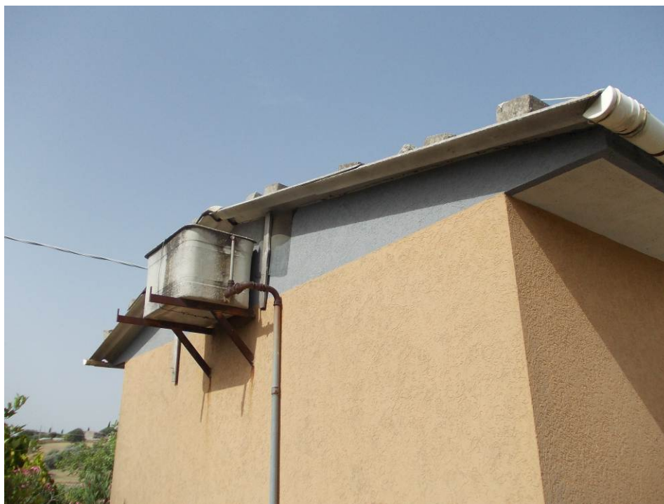
Foto 19 (copertura con lastre di fibrocemento)
