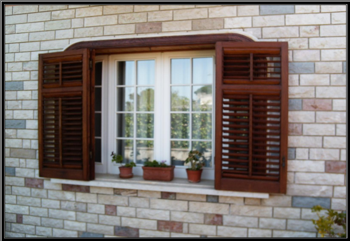
rilievo fotografico n° 3: particolare infisso esterno
