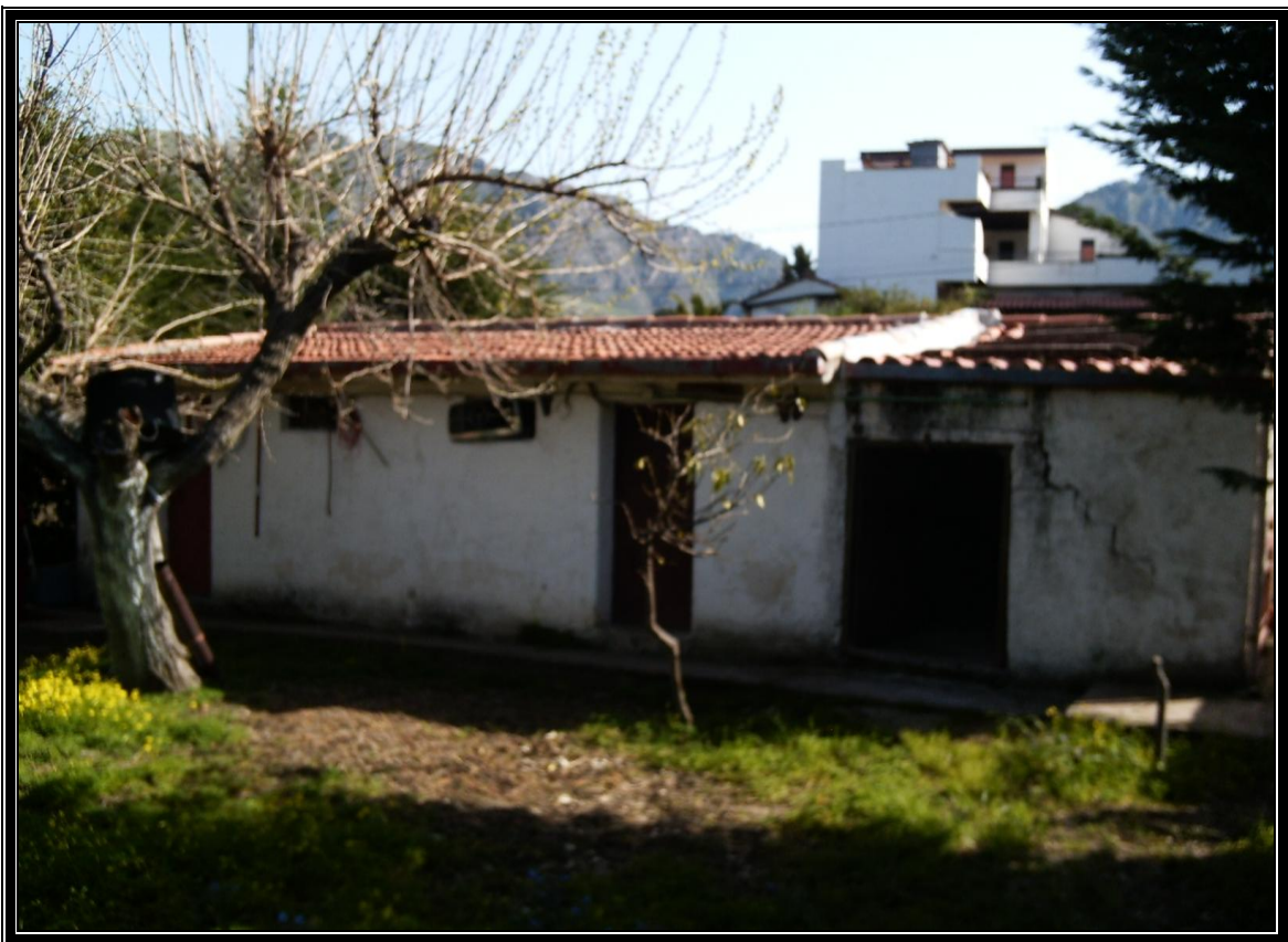
rilievo fotografico n° 4: corpo basso ripostiglio
