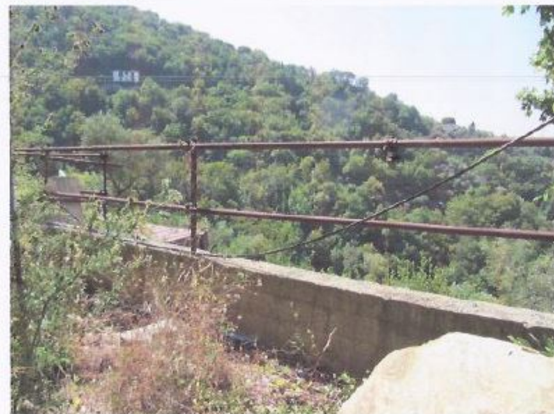
Area esterna dell'edificio in costruzione (piano terra)
