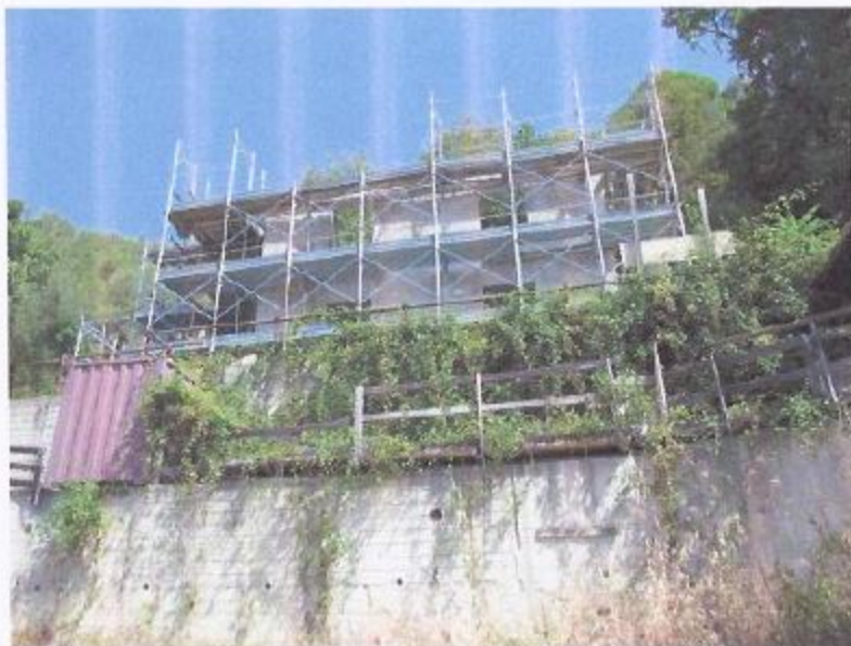
Vista dell'edificio in costruzione
