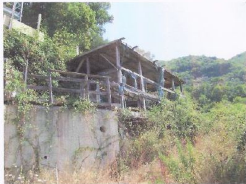
Vista verso la prosecuzione della rampa
