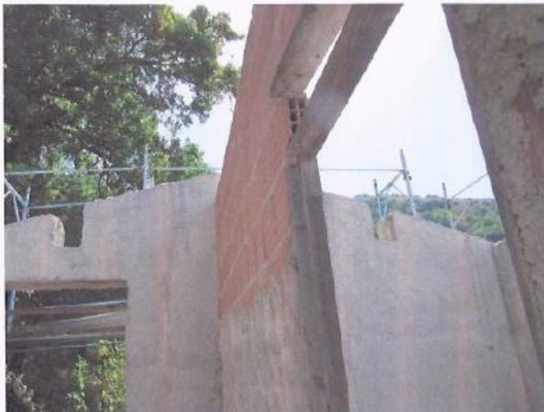
Edificio in costruzione (primo piano)
