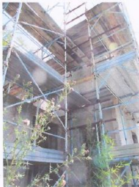
Esterno dell'edificio in costruzione
