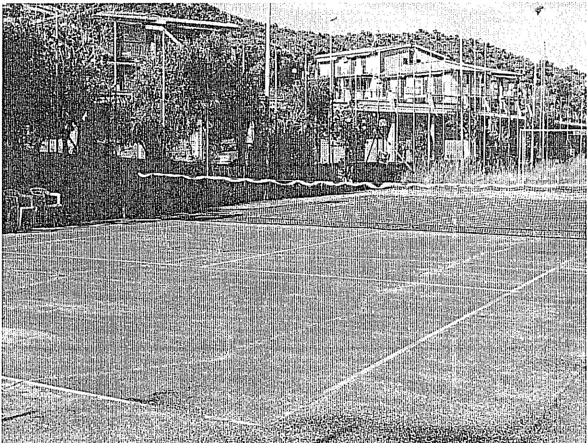
Foto n. 6. Altra inquadratura del campo. Son ben visibili le lunghe lesioni del pavimento in asfalto.
