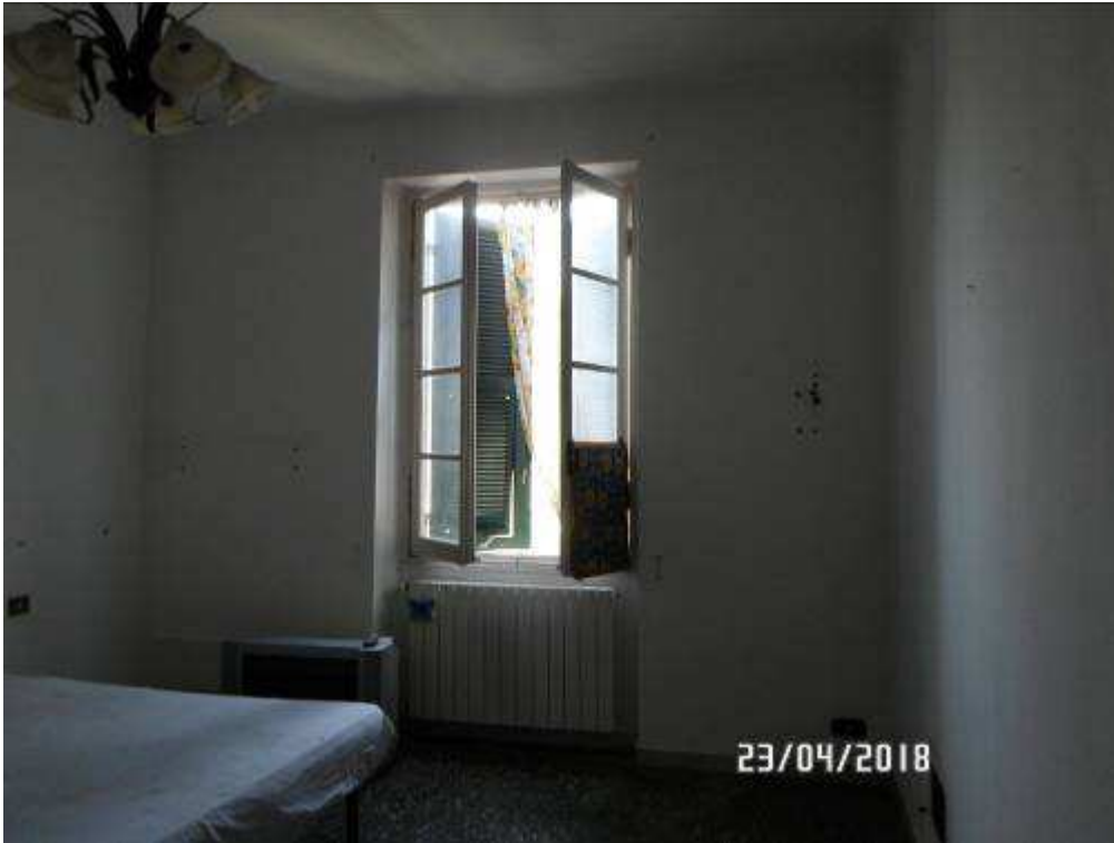
FOTO N. 5 Ripresa della camera da letto.
