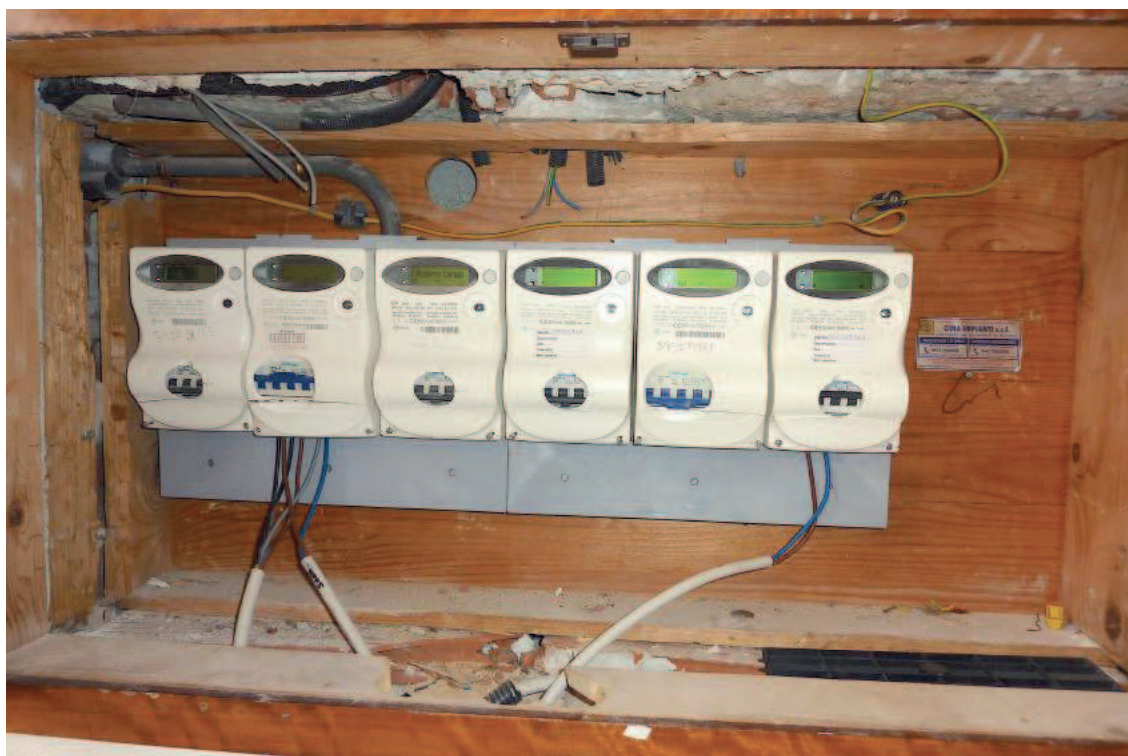
Foto 14 – contatore elettrico
