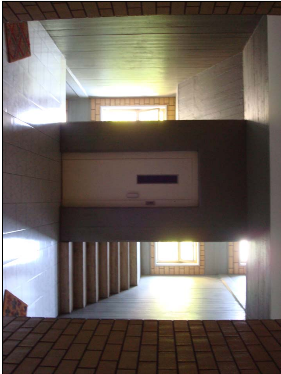
Foto n. 06 – Vista ascensore e vano scala.
