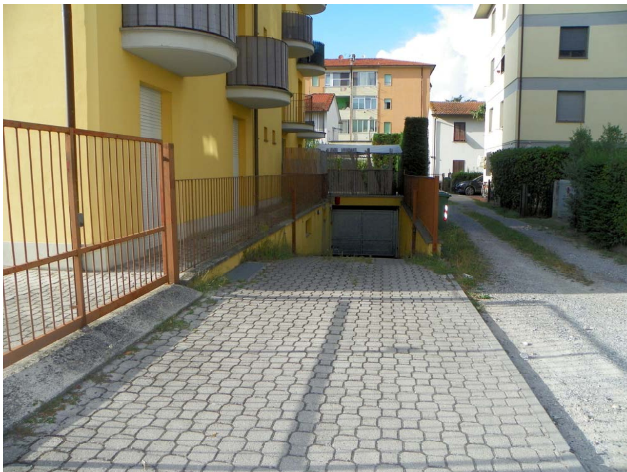
5 - Rampa di accesso al Piano Interrato
