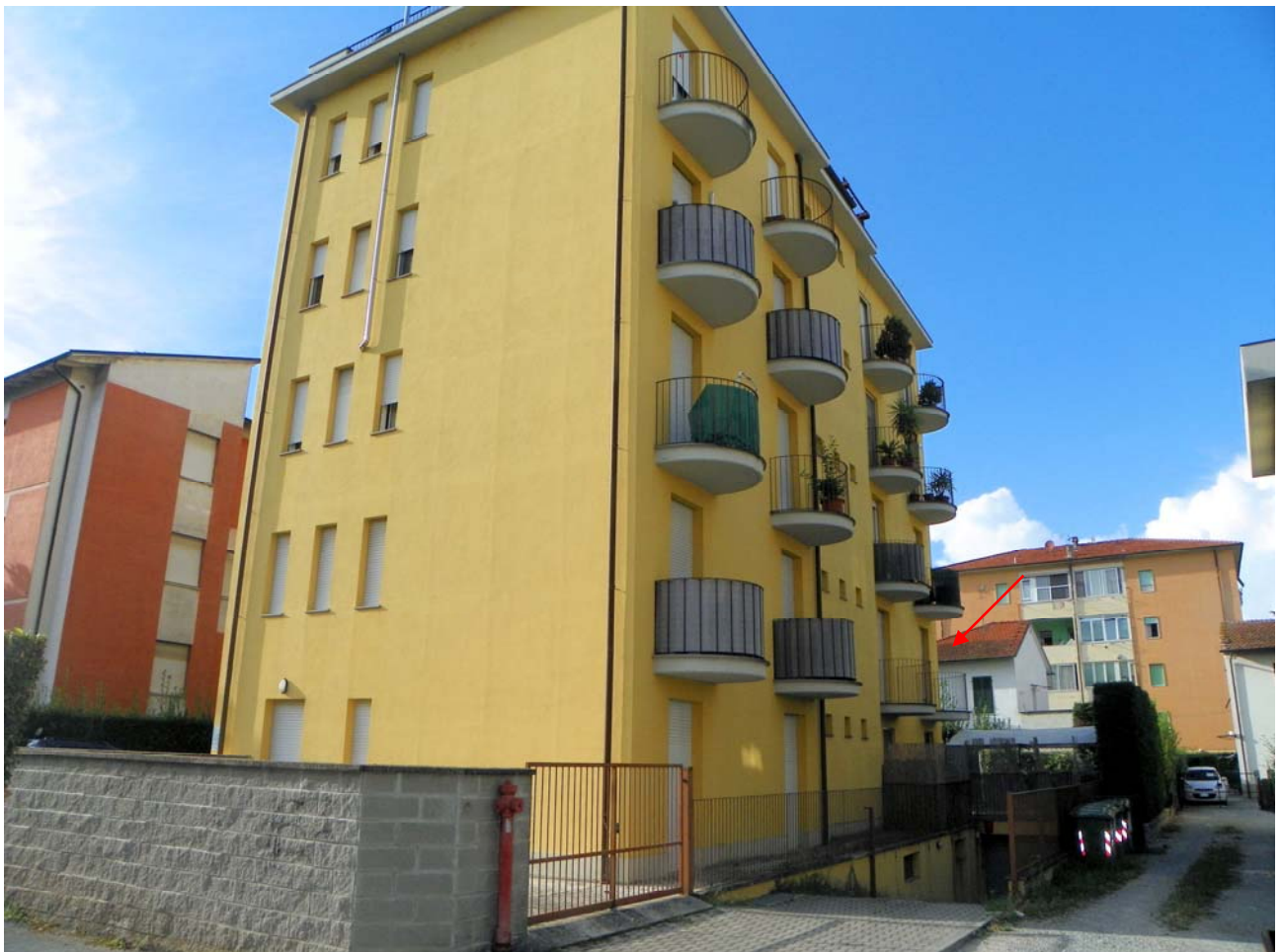
4 - Vista del fabbricato Lato Sud- Est
