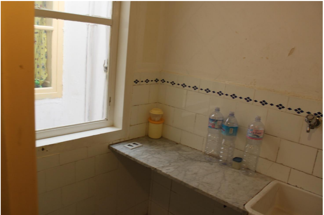
Vano lavanderia al primo piano
