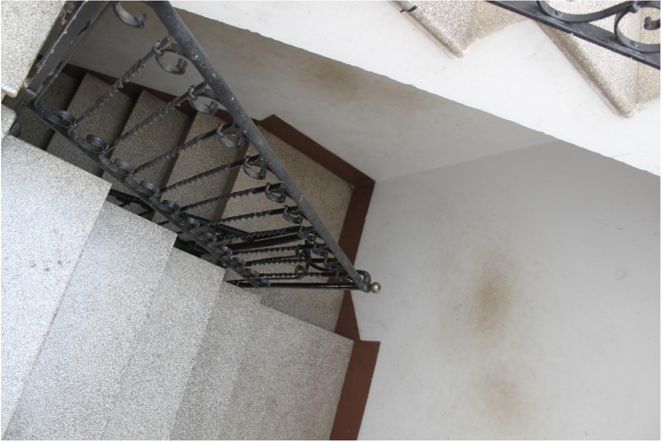
Scala di accesso al secondo piano
