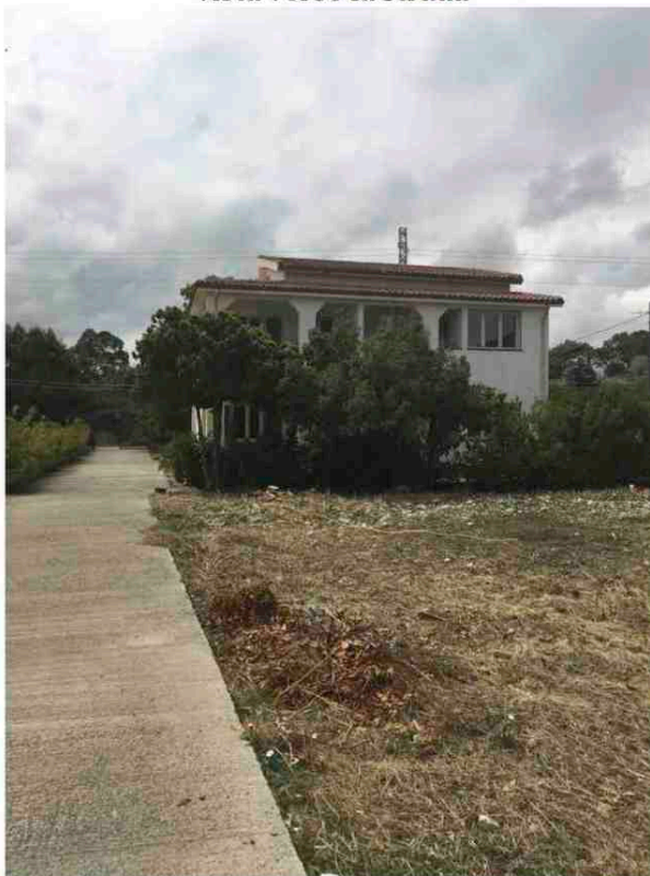
fotografia n. 1 vista verso la strada
