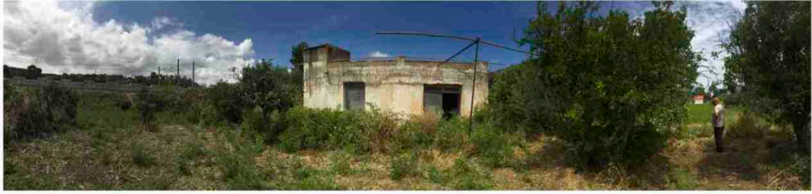
6° Lotto fig. 1 p.la 753 rudere in Campofelice di Roccella
