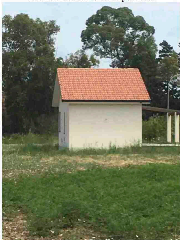
foto n. 9 fabbricato con il porticato
