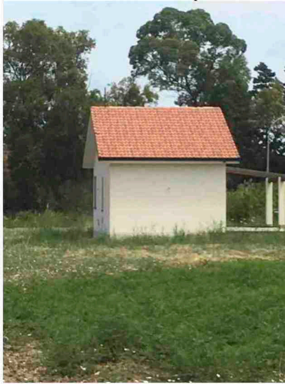
foto n. 9 fabbricato con il porticato
