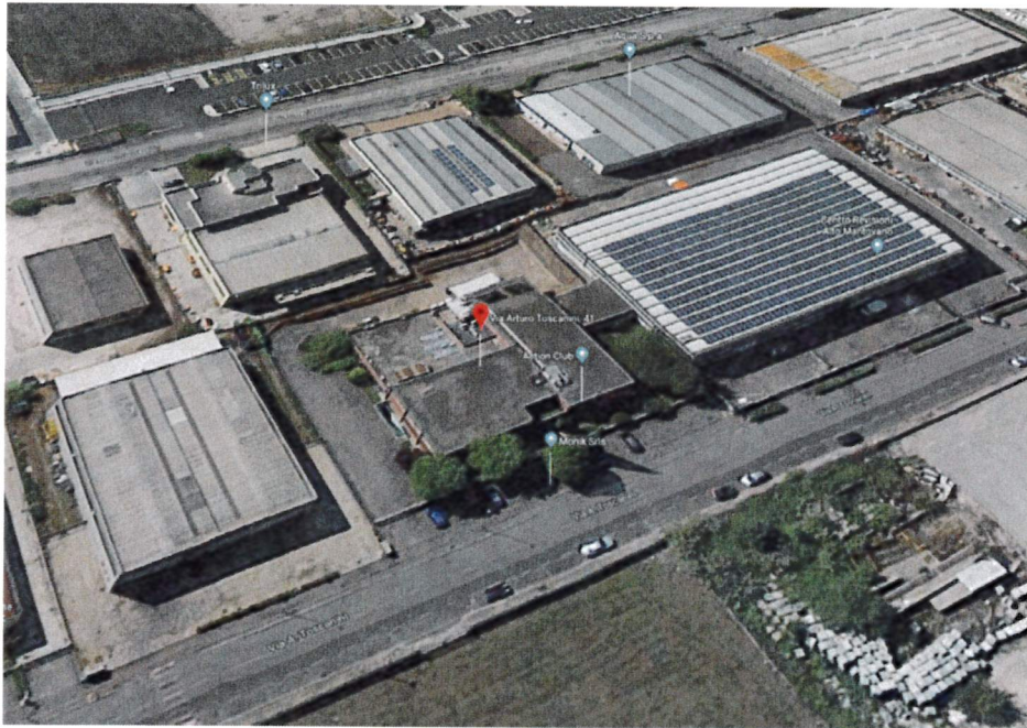
Foto n° 1: Vista aerea dell'intero complesso
