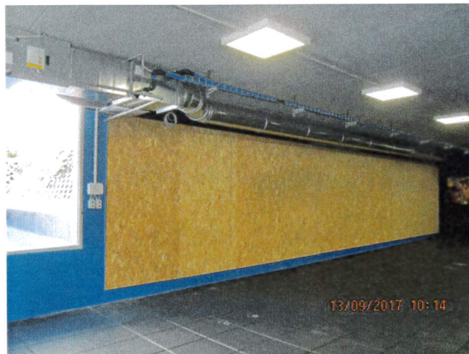
Foto n° 10: Vista interna palestra
