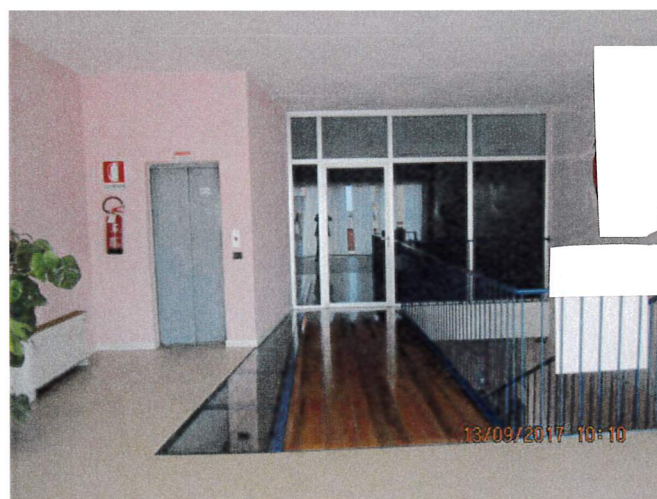
Foto n° 2: Vista ballatoio al piano primo
