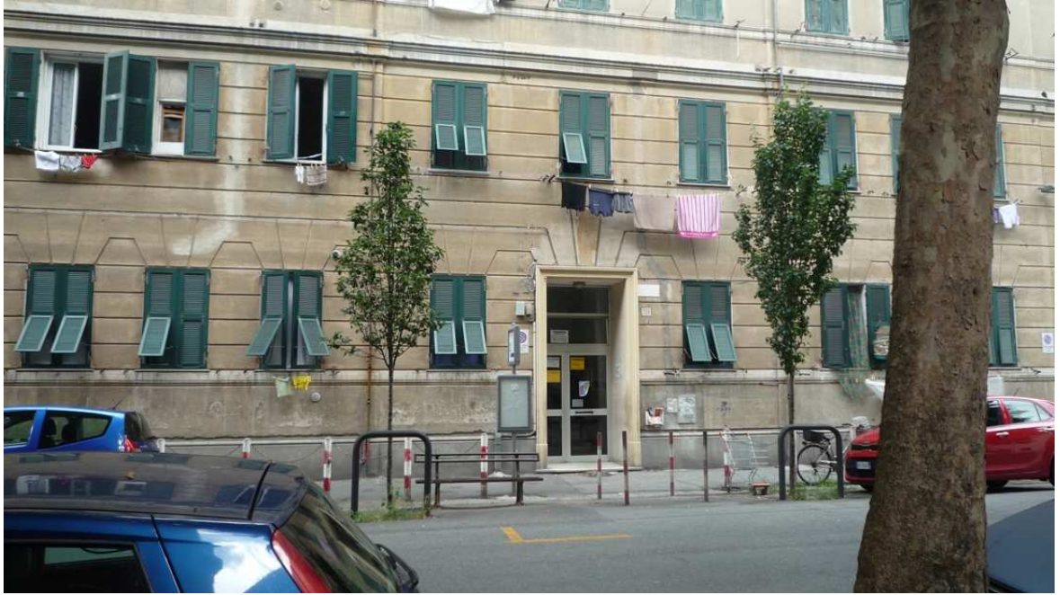
Vista portone di ingresso principale civ.64 Via Bolzaneto - Fotografia 1
