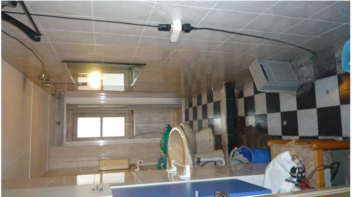
Vista bagno civ. 86 - Fotografia 13
