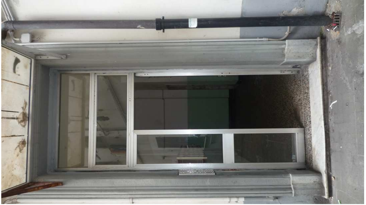
Portone di accesso scala D civ. 64 via Bolzaneto - Fotografia 5
