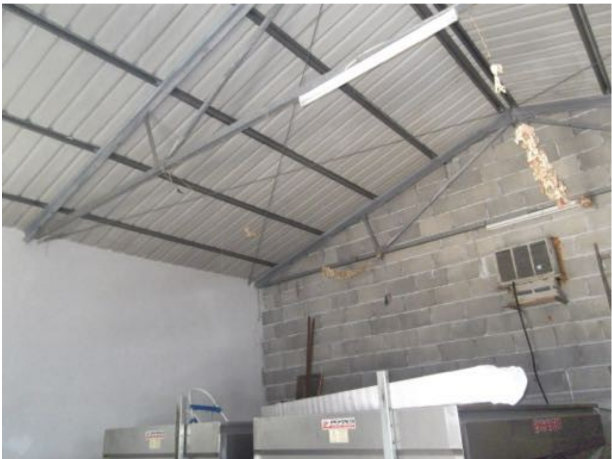
Foto n.10 vista del magazzino rurale
