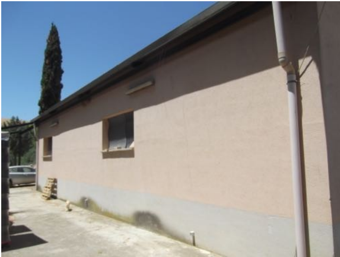
Foto n.5- vista laterale del magazzino rurale
