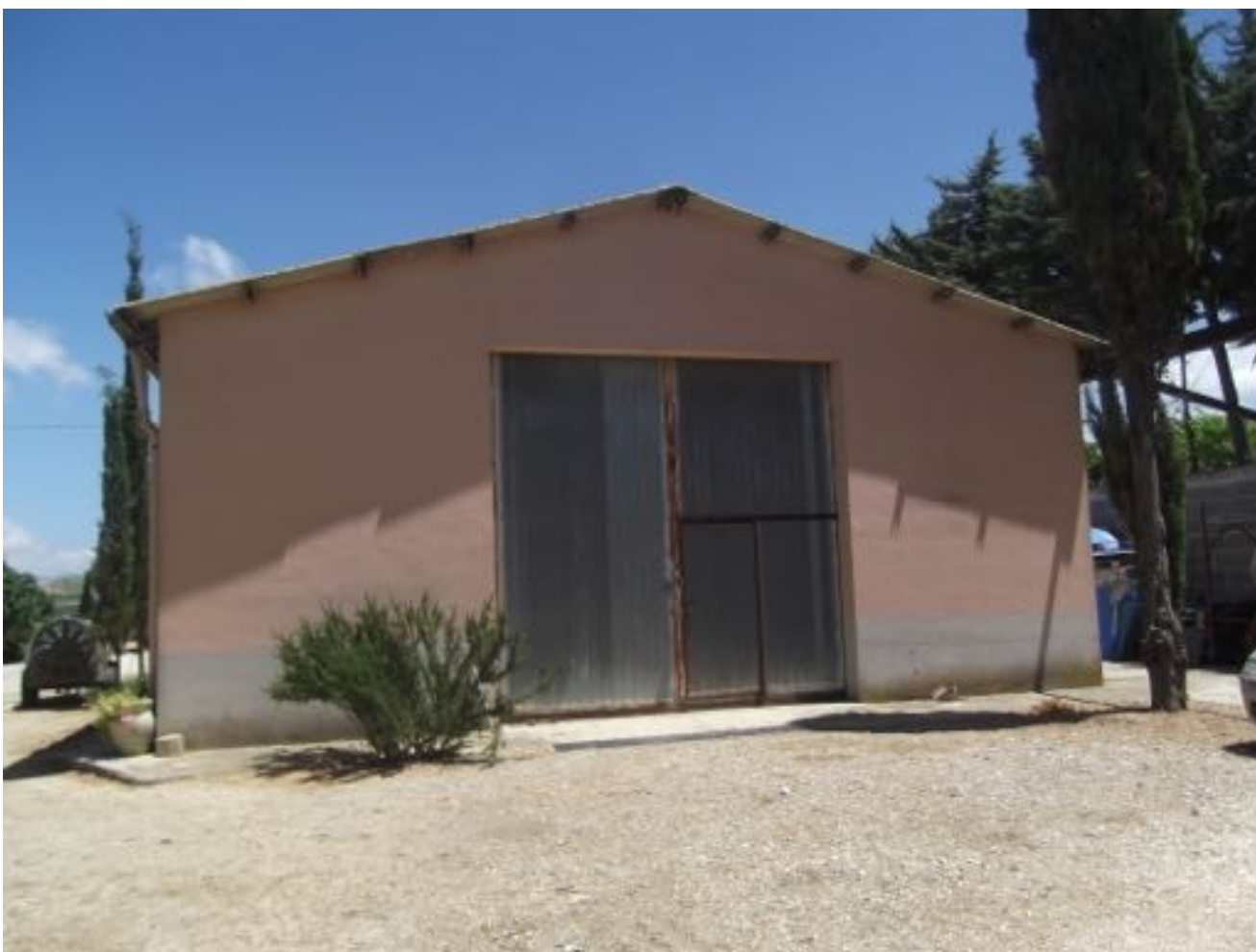
Foto n.6 vista del fronte sud del magazzino rurale
