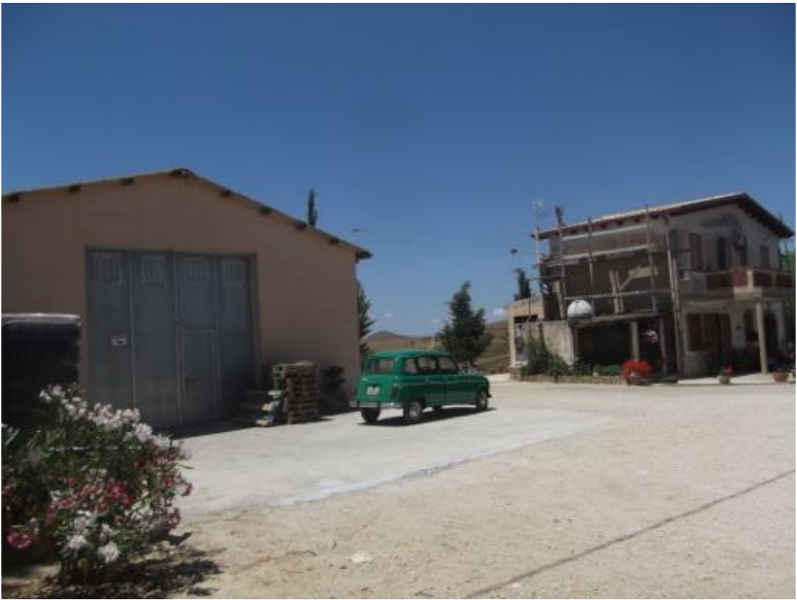
Foto n.3- vista del magazzino rurale in CT f.191 p.lla 332 e dello spiazzale antistante
