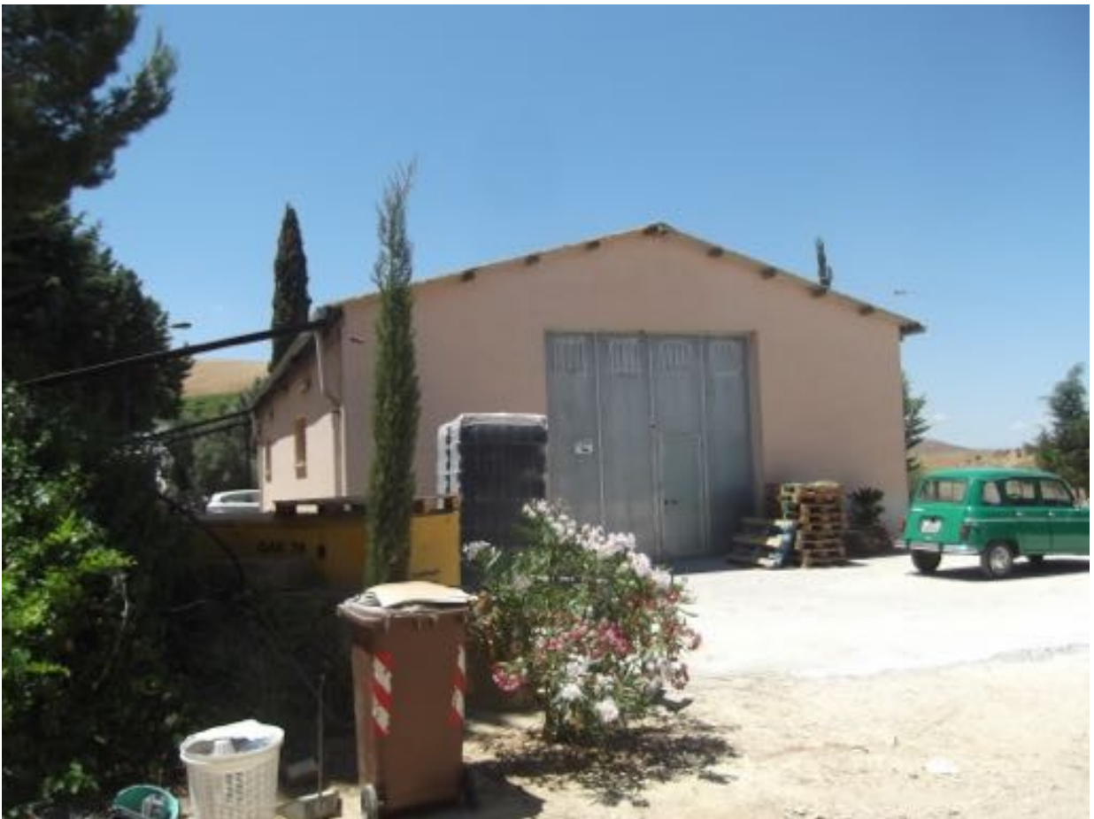
Foto n.4- altra vista del magazzino rurale
