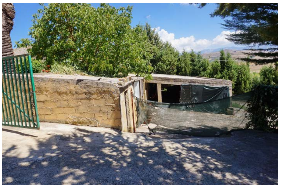
foto 12 - vista esterna dell'ovile (corpo D)
