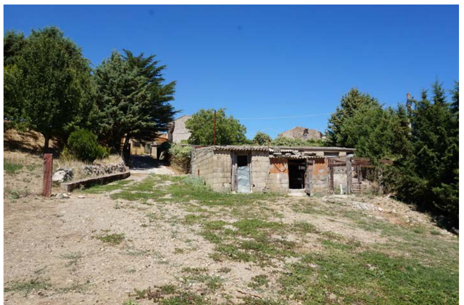
foto 9 - vista esterna della porcilaia (corpo E)
