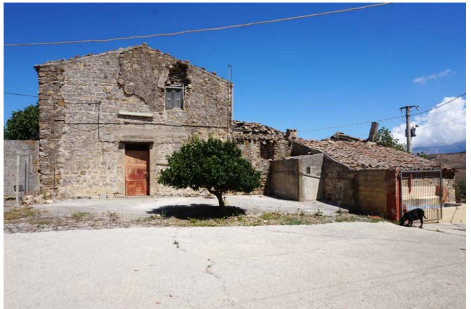
foto 8 - vista esterna del fabbricato rurale (corpo F)
