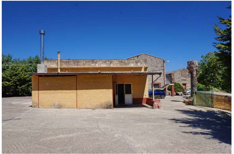
foto 19 - ingresso alla sala degustazione (corpo B)
