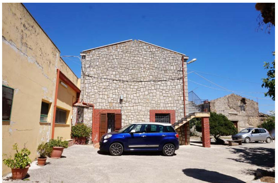
foto 21 - vista esterna delle abitazioni (corpo A)
