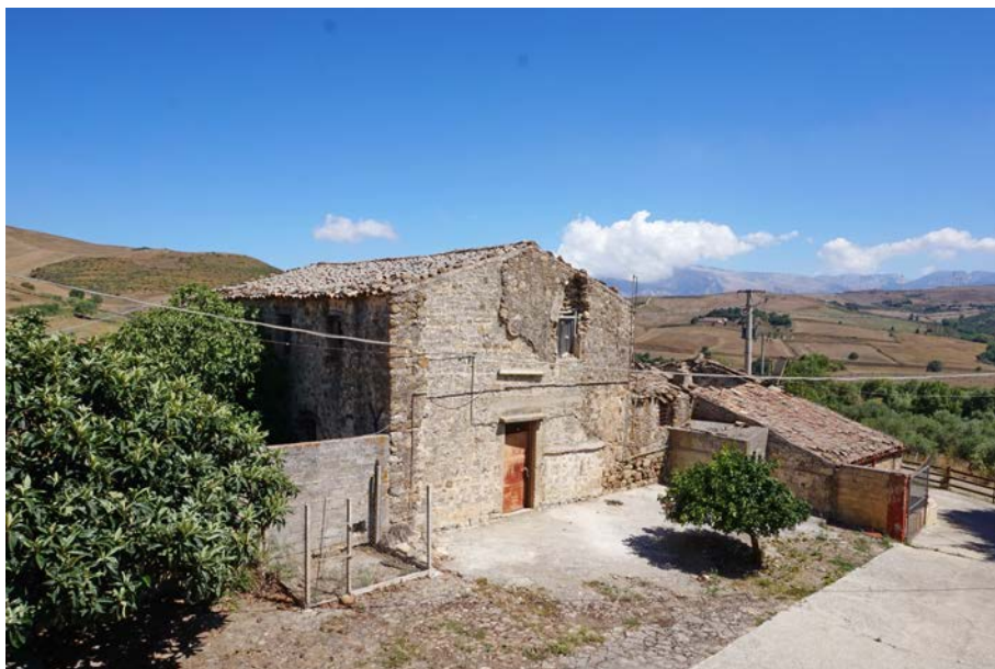
foto 22 - vista esterna del fabbricato rurale (corpo F)
