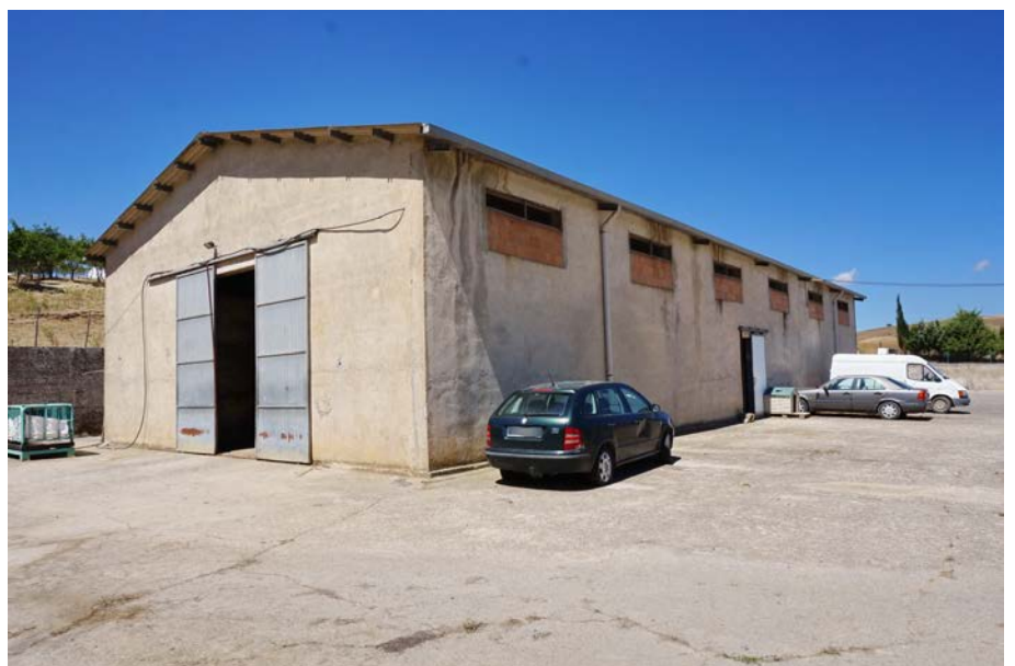
foto 15 - vista esterna del fienile (corpo C)
