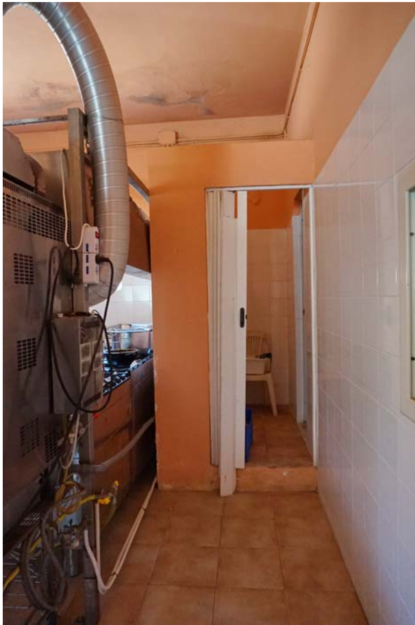
foto 49 - ingresso ai bagni zona degustazione (corpo A)
