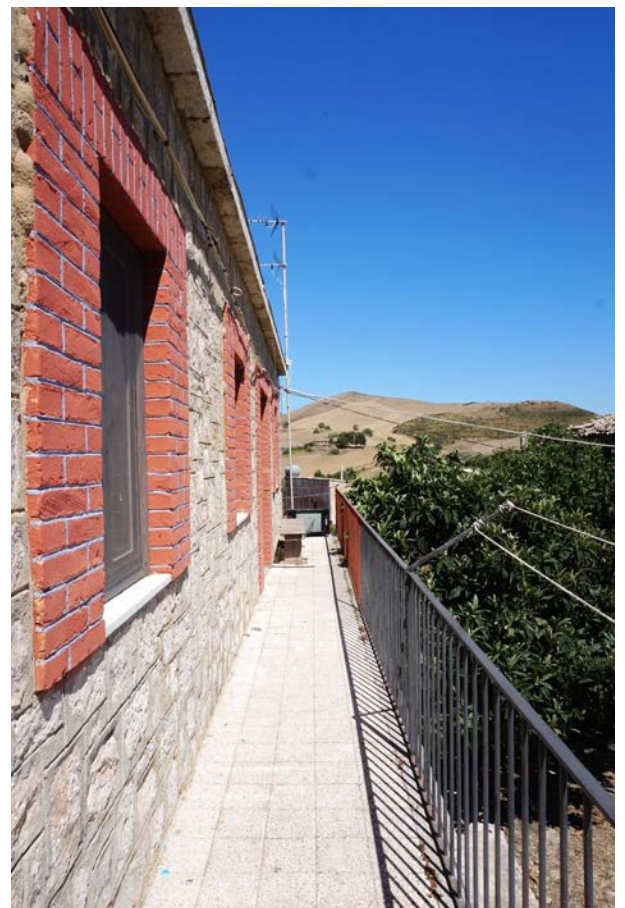
foto 38 - balcone al primo piano (corpo A)
