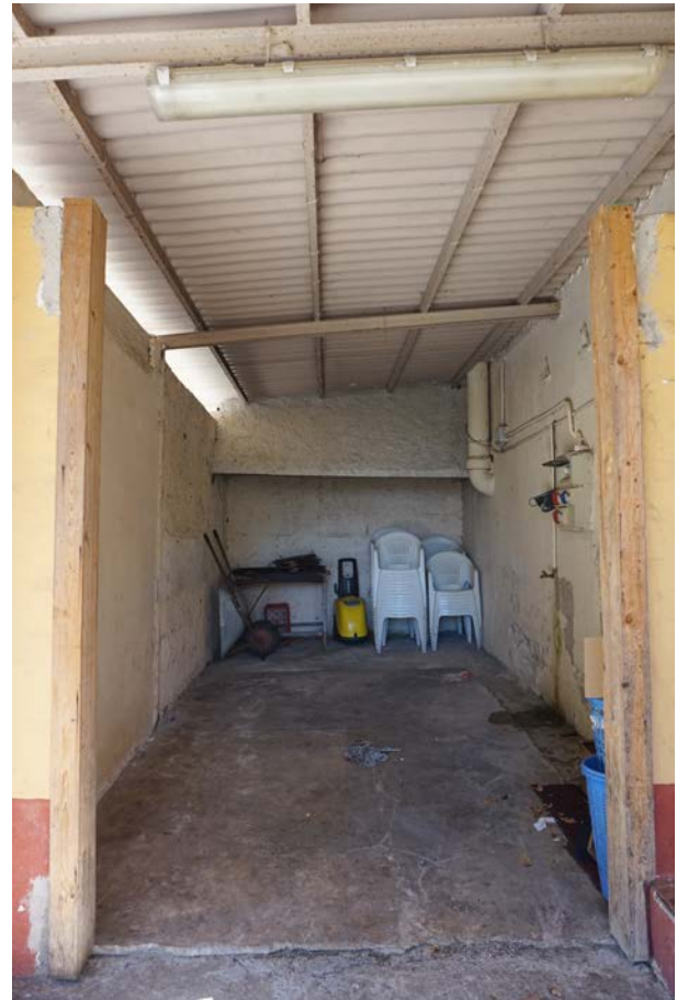
foto 46 - tettoia cucine zona degustazione (corpo A)
