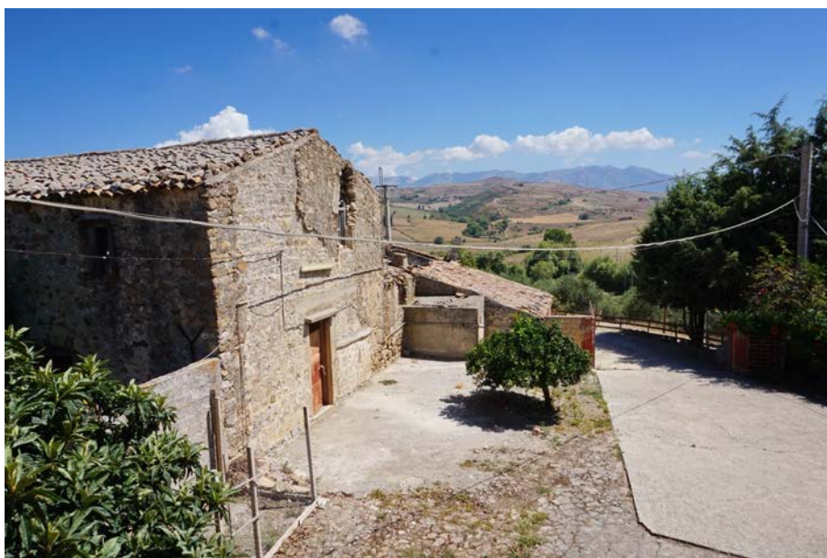
foto 44 - vista verso l'ingresso dal primo piano (corpo A)
