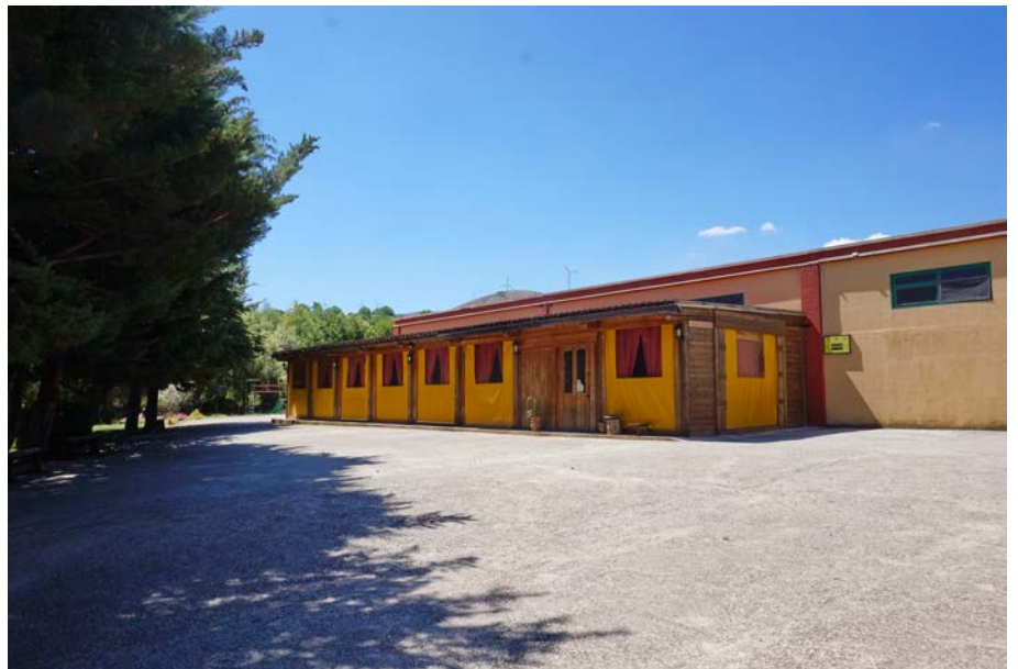
foto 20 - vista esterna del caseificio (corpo B)
