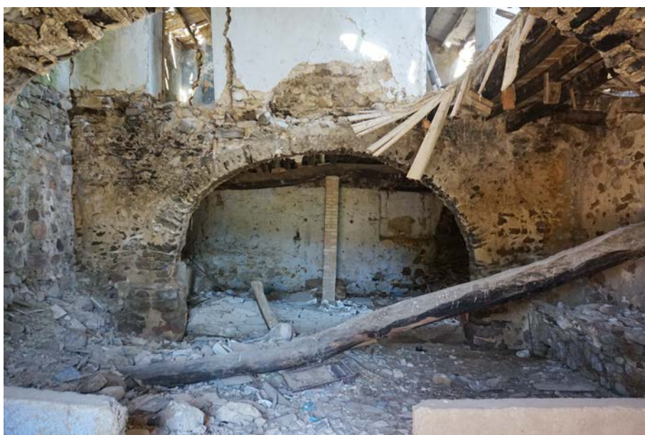
foto 23 - vista interna del fabbricato rurale (corpo F)
