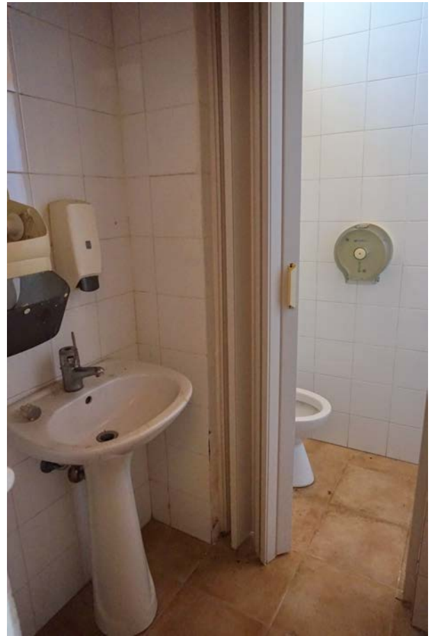
foto 50 - bagno zona degustazione (corpo A)
