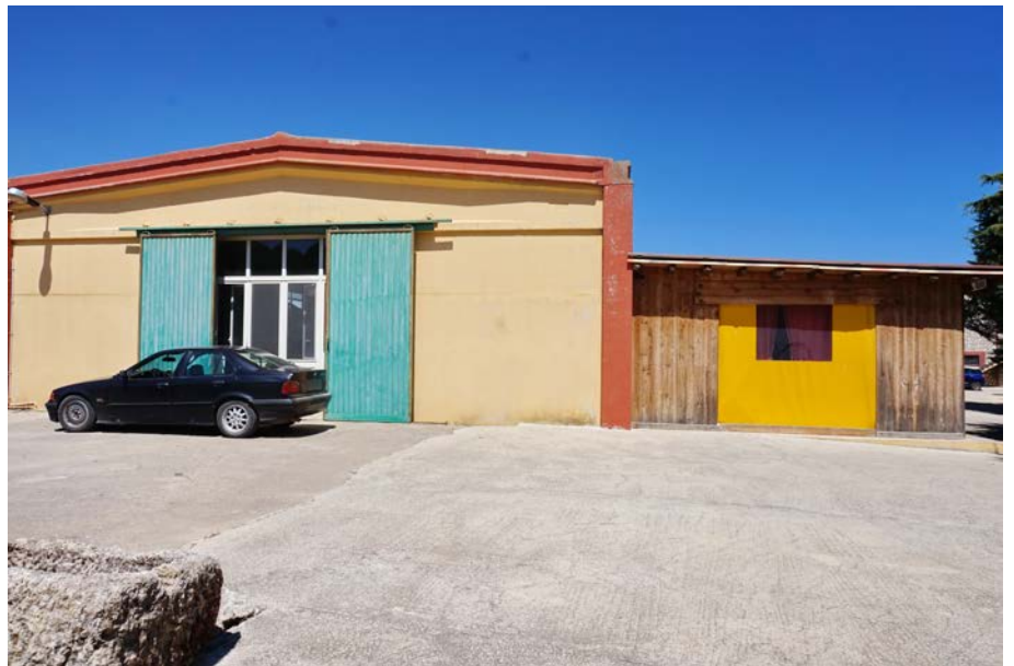
foto 17 - vista esterna del caseificio (corpo B)
