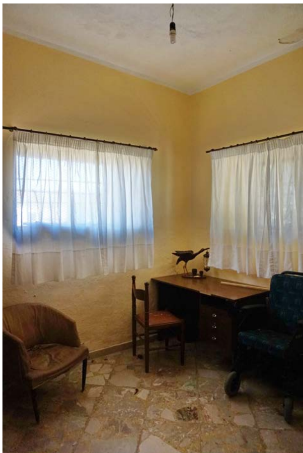
foto 33 - camera al piano terra (corpo A)
