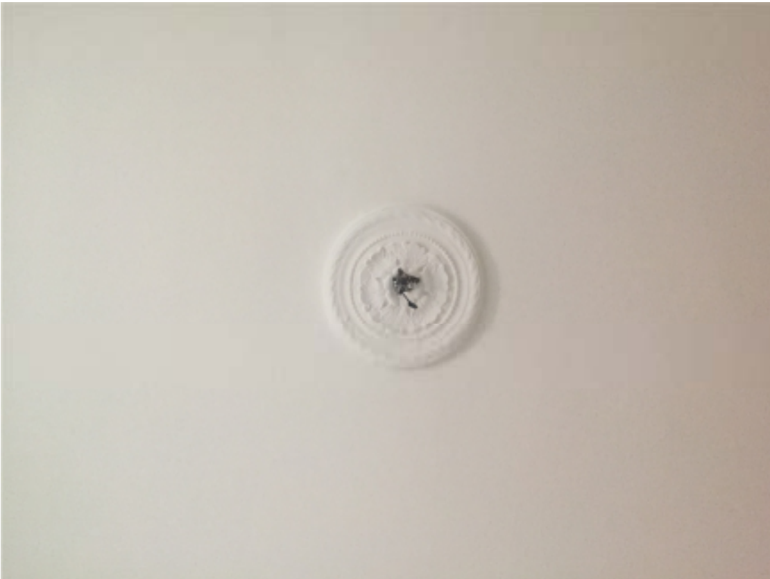
Foto nn. 23 e 24 - Elementi decorativi a stucco nei soffitti
