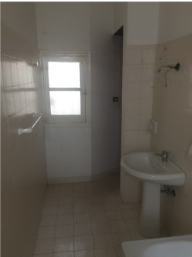
Foto nn. 19 e 20 - W.C. Bagno
