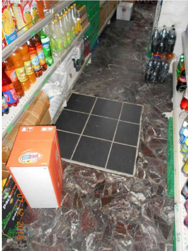
FOTO N. 16 – PARTICOLARE BOTOLA MURATA
