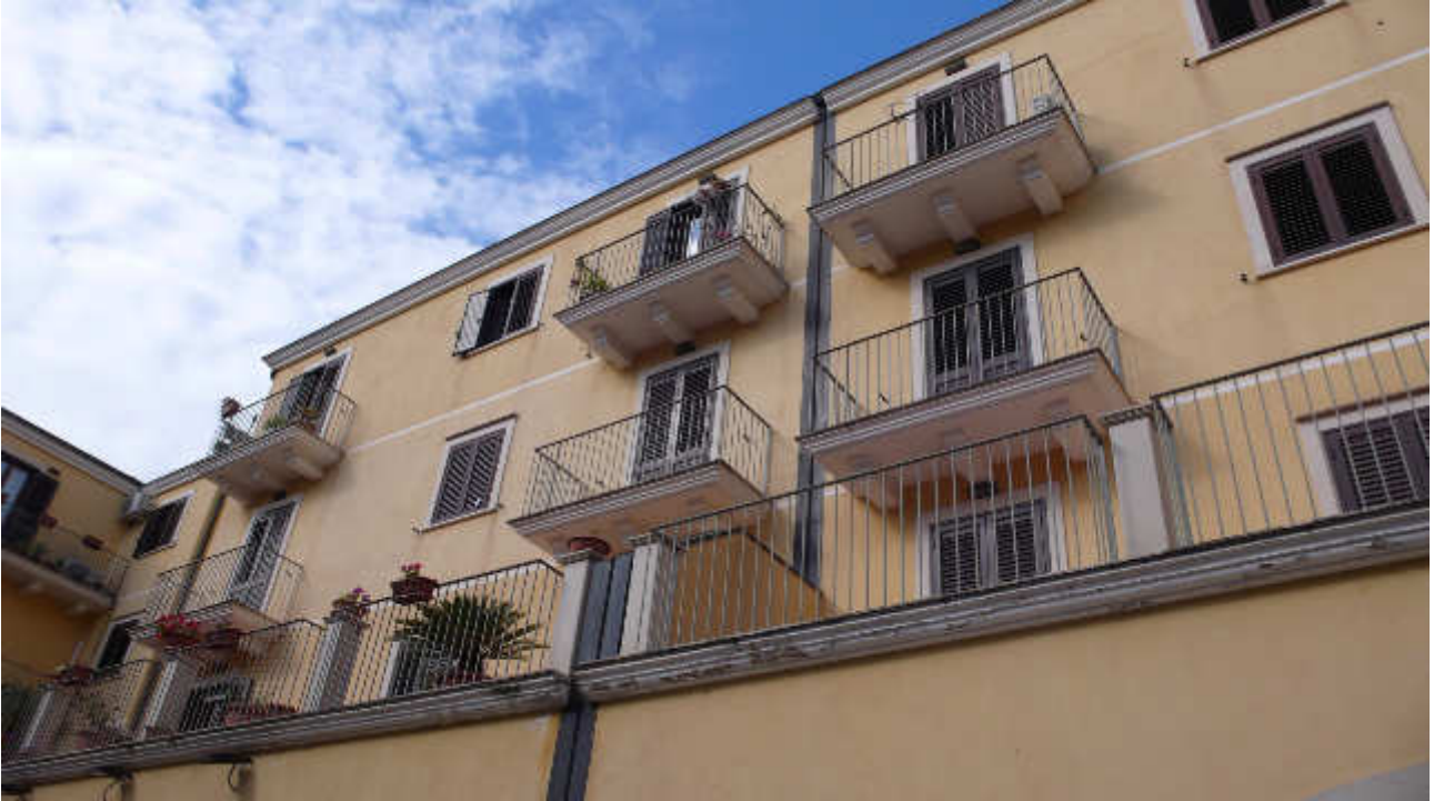
FOTO 1 - PROSPETTO PRINCIPALE SU VIA MODICA SORDA.
