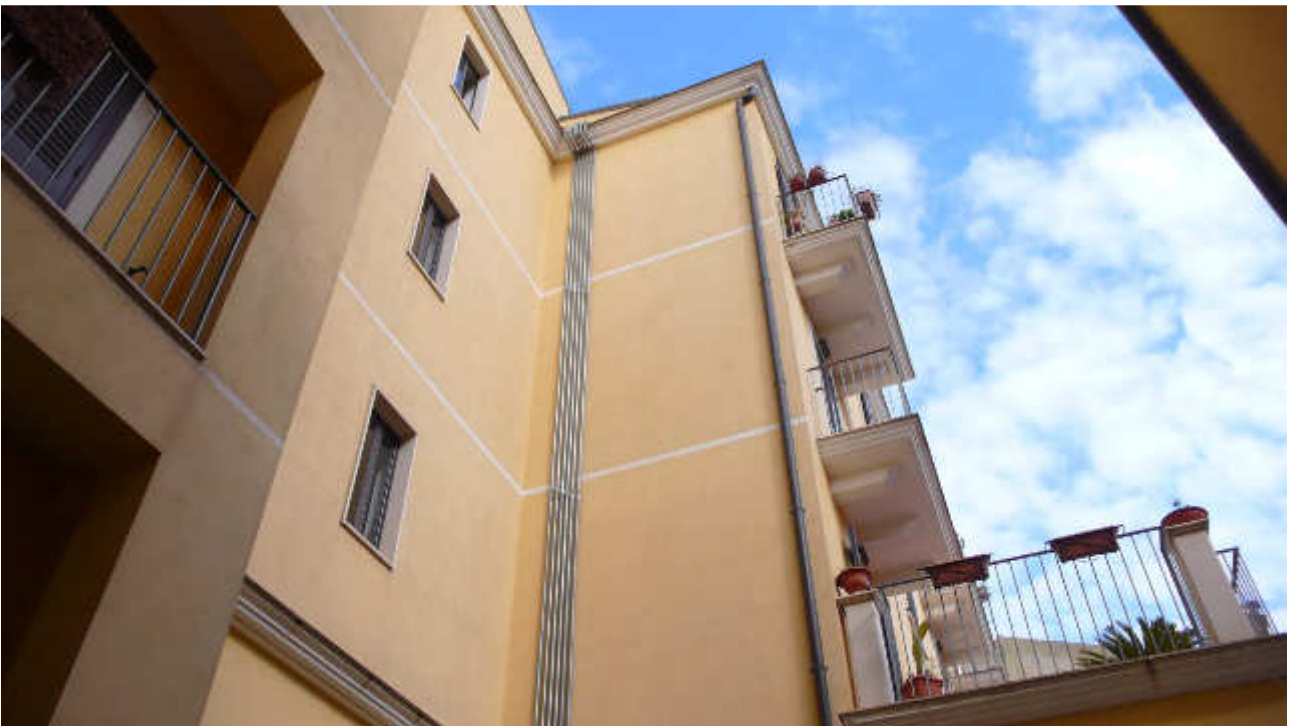
FOTO 2 - PROSPETTO PRINCIPALE SU VIA MODICA SORDA.
