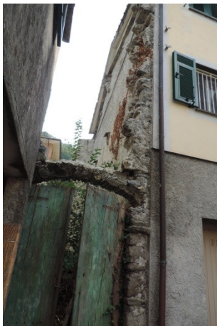
Foto Esterna su Via Manzi
