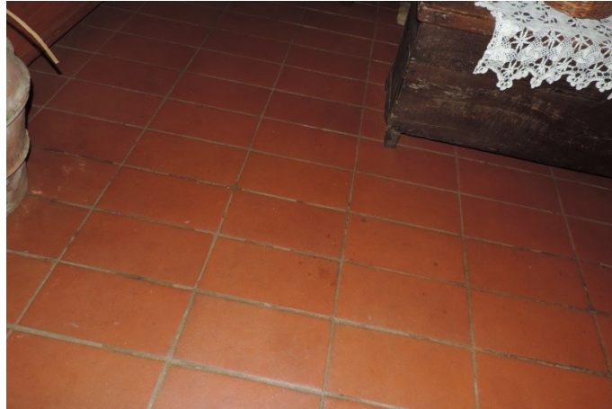
Pavimentazione del disimpegno di ingresso
