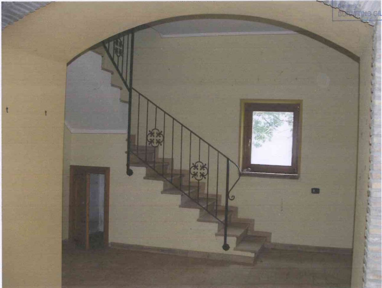
Vista interna scala di accesso al piano primo - dal locale soggiorno piano terra
