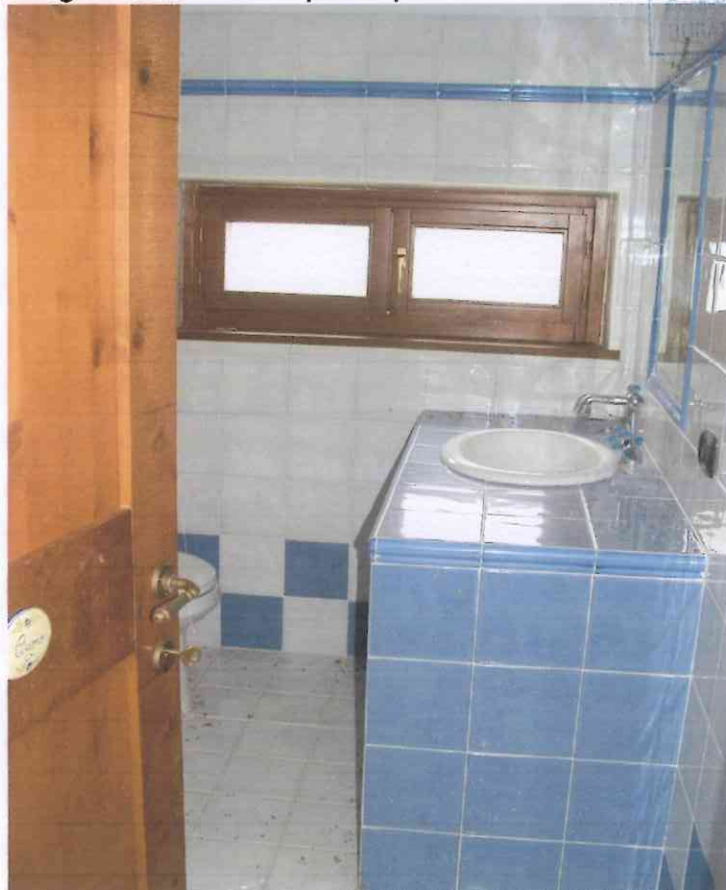
Particolare secondo bagno zona notte – piano primo
