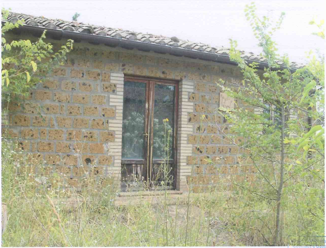
Particolare annesso - magazzino - vista dal fabbricato principale
