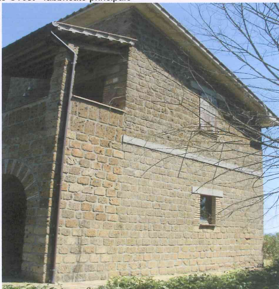
Prospetto lato Ovest - fabbricato principale
