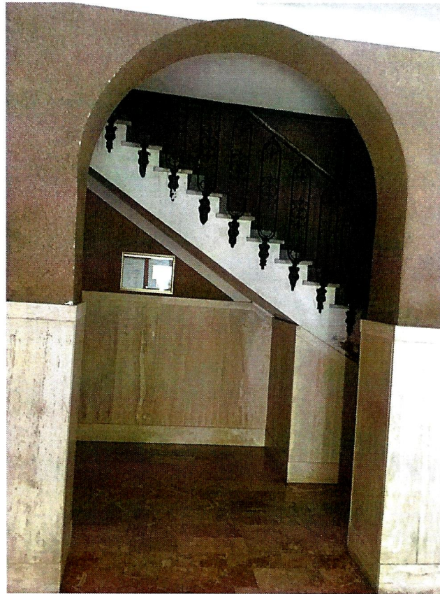
Foto n. 7- Atrio ripreso verso il vano scala
