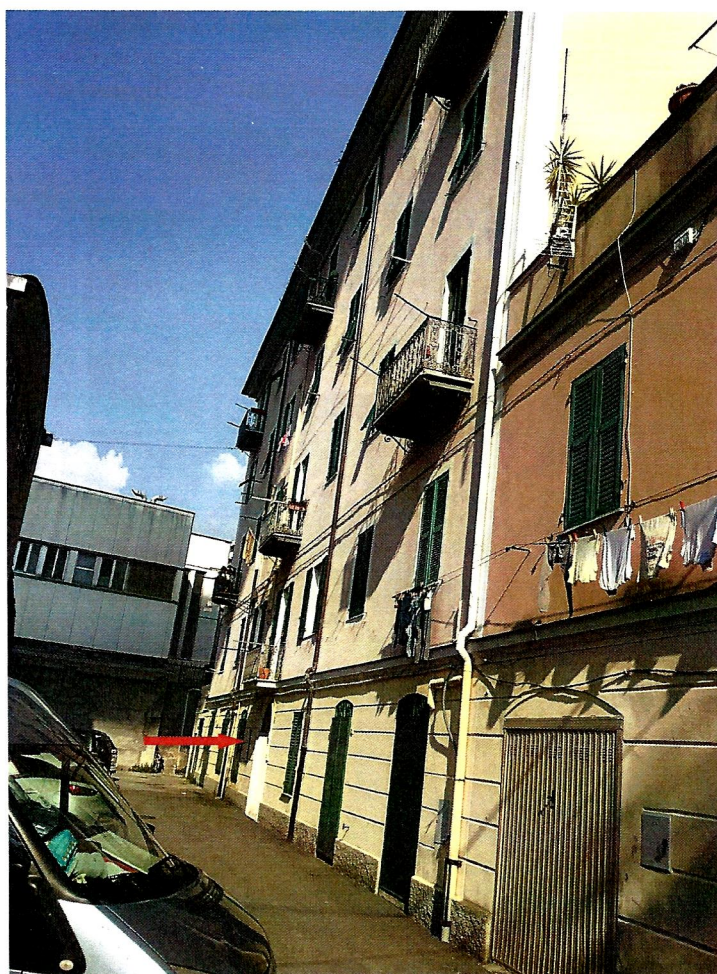
Foto n. 4 – Via Laiasso civ. 10 , in evidenza il portone di accesso.
