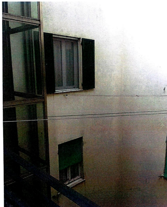
Foto n. 12 – Cavedio ripreso dalla passerella. A sinistra il vano corsa dell'ascensore.
