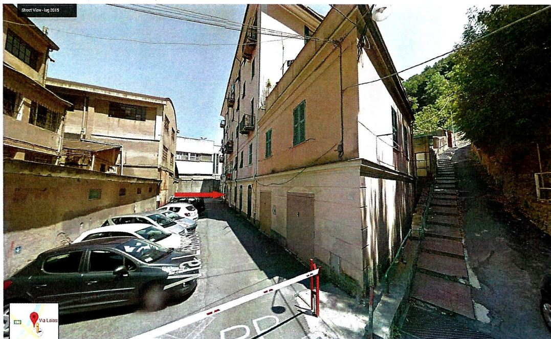
Foto n. 3 – Via Laiasso civ. 10 , in evidenza il portone di accesso e il parcheggio condominiale .
