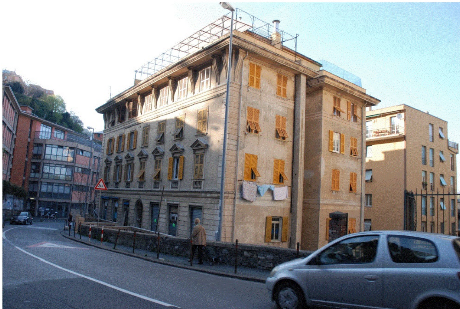
Foto n. 1 – Edificio civico 36 via L.Montaldo, Genova
