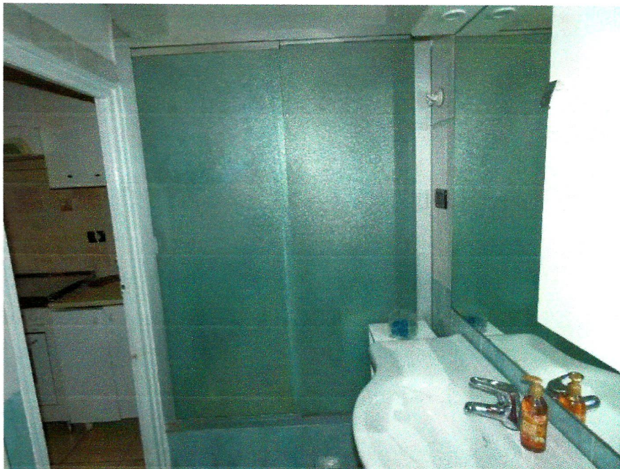
Servizio igienico - Fotografia n°16
