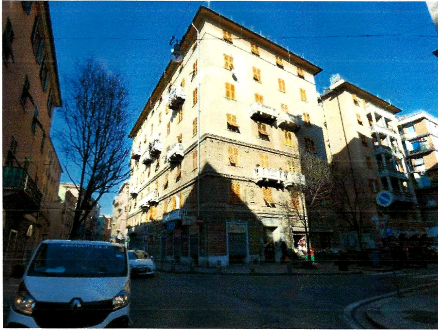
Vista generale fabbricato Via Enrico Dandolo civ. 2 - Fotografia n°1
