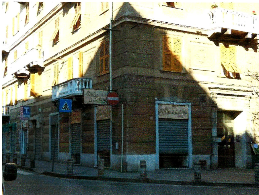
Vista particolareggiata piano 1° - Fotografia n°2
