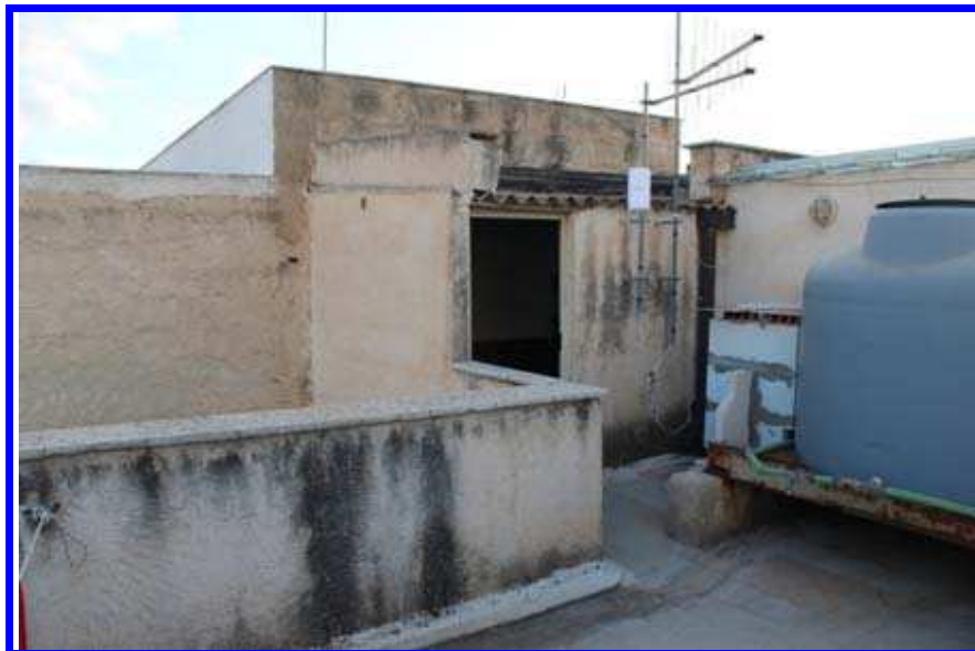
Foto 33 – Locale sgombero (copertura in cemento-amianto)
