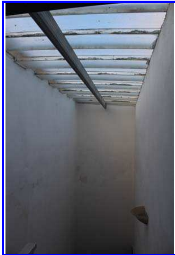
Foto 30 - Vano Scala (SUB.4)
