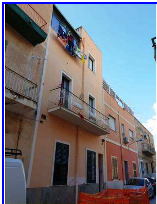
Foto 2 - Prospetto su Via Sicilia
