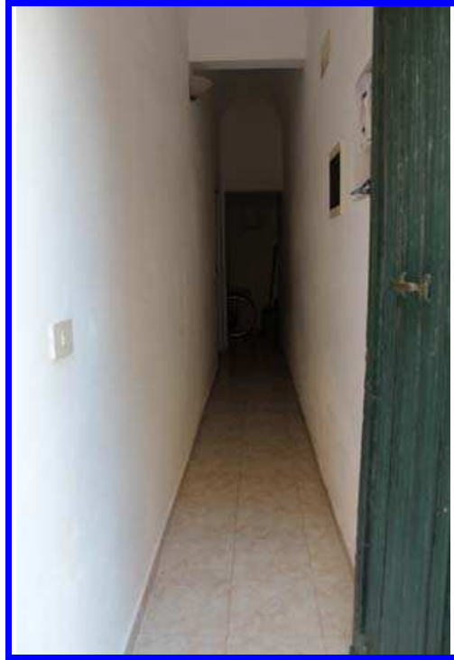
Foto 3 – Ingresso vano scala (SUB.4)
