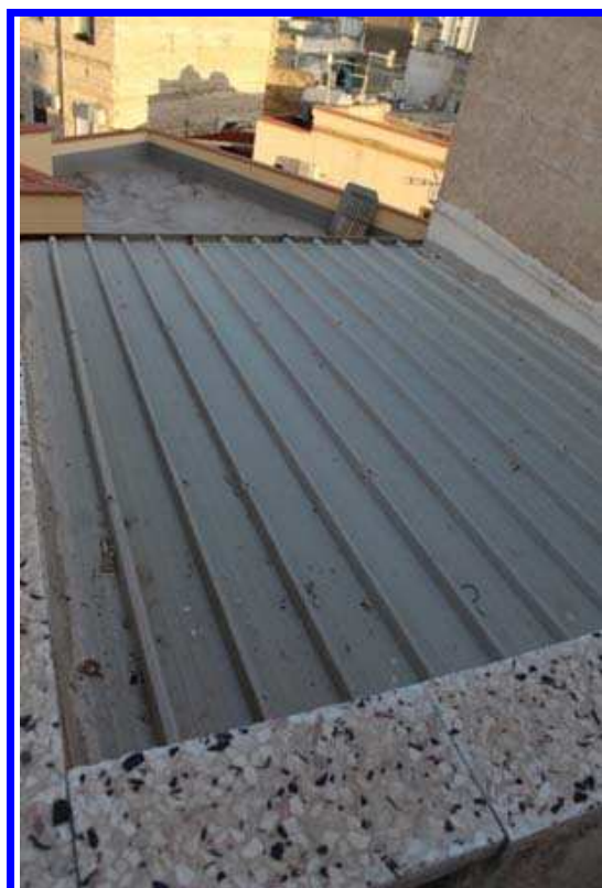
Foto 32 – copertura in coibentato del Vano soggiorno/pranzo del P.2°
