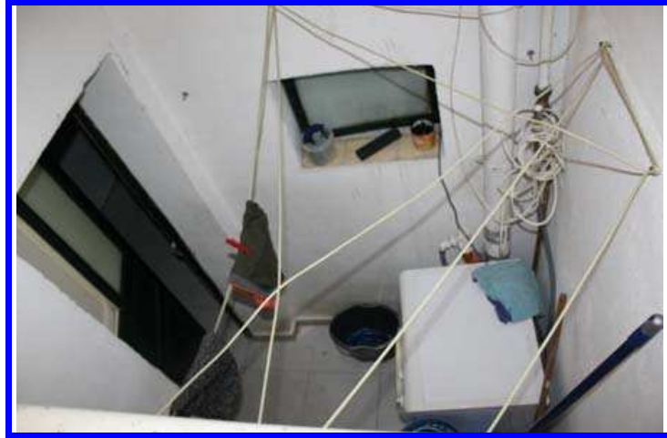
Foto 9 – Pozzo luce vano scala (SUB.4)
