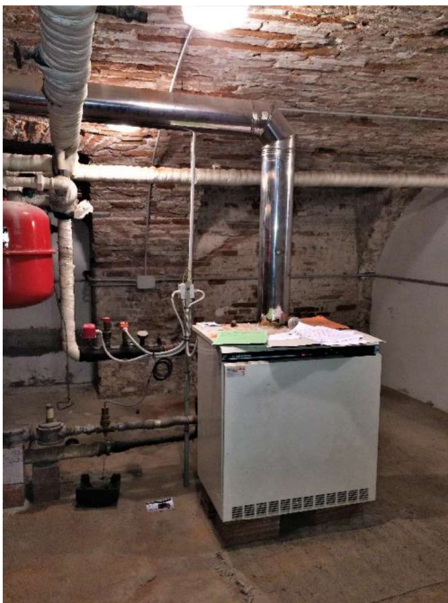
Cantina con caldaia centralizzata
