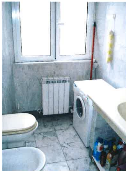
Vista del bagno con affaccio sul prospetto nord
