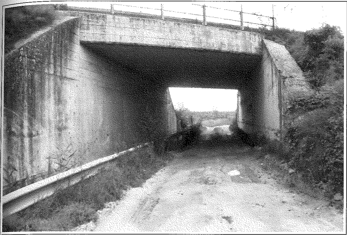
FOTO N°25: PARTICOLARE DEL SOTTOPASSO CHE ATTRAVERSA LA DIRETTISSIMA
