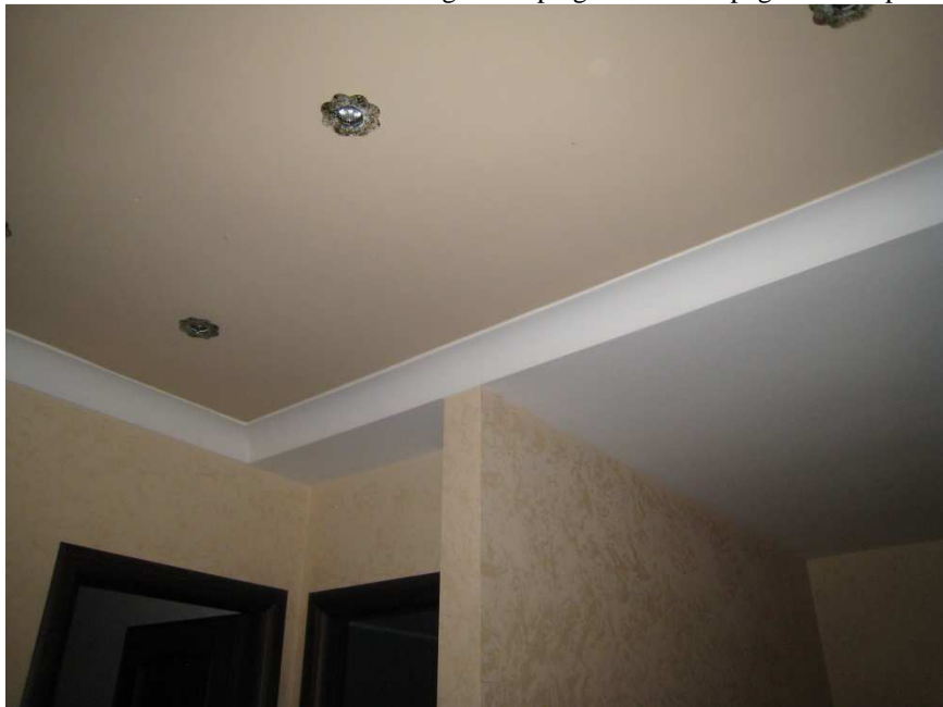
Foto n. 23 e 24. Il contro soffitto ed i gessi impiegati nel disimpegno del 2° piano.
