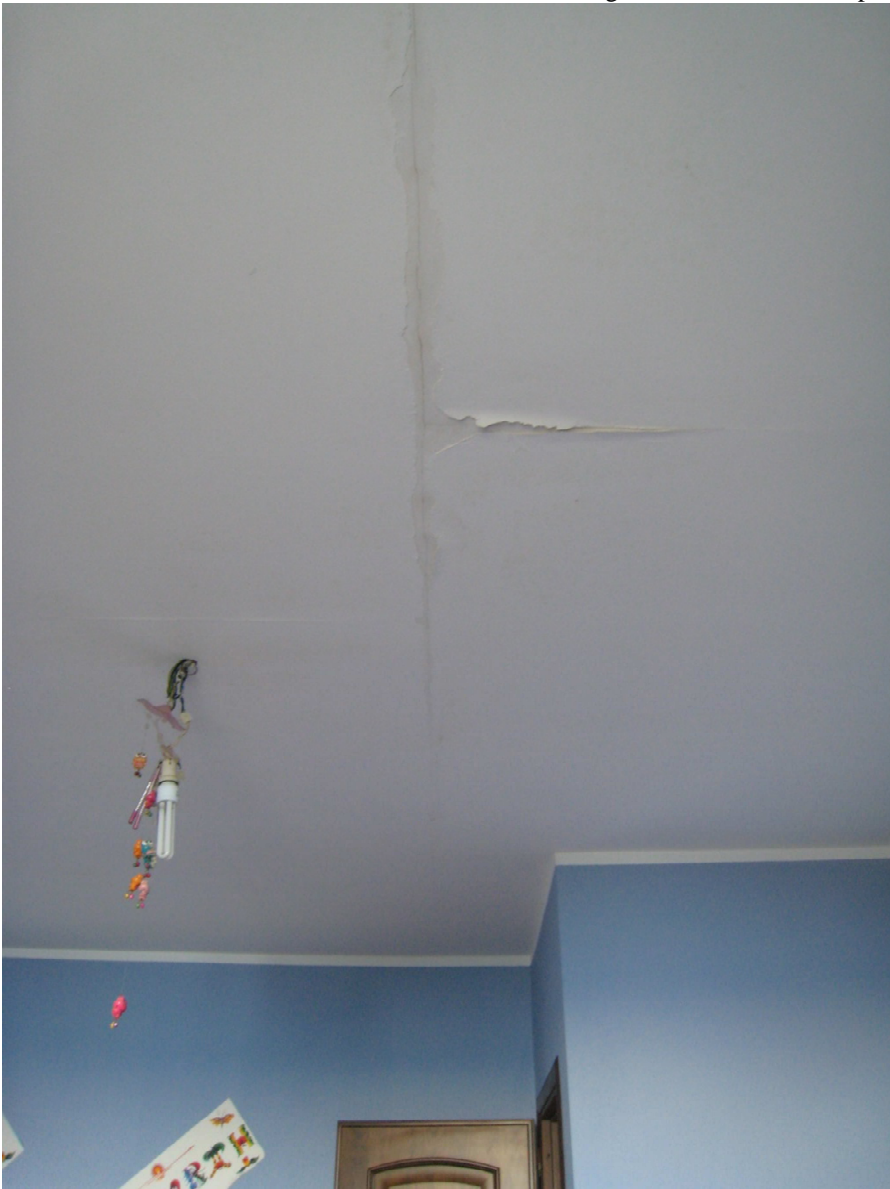
Foto n. 20 e 21. Le condizioni in cui versa il soffitto a seguito delle infiltrazioni provenienti dal tetto.
