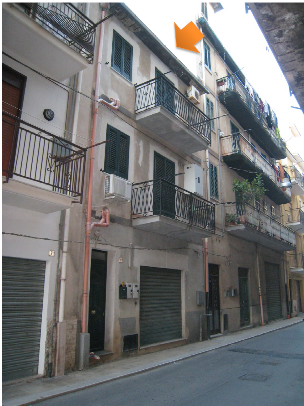
Foto n. 1. Il prospetto su Via Luigi Di Vanni.
