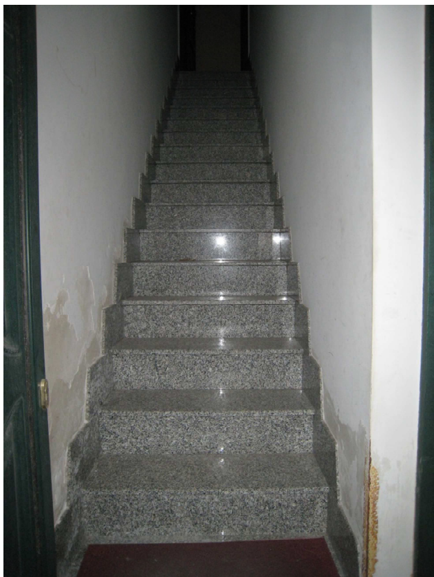
Foto n. 4. La prima rampa di scale: P.T.-1° piano.
