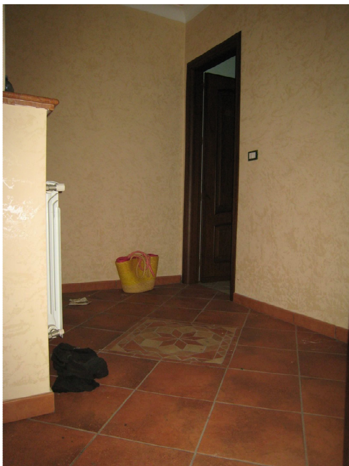
Foto n. 14. Il disimpegno del 2° piano.
