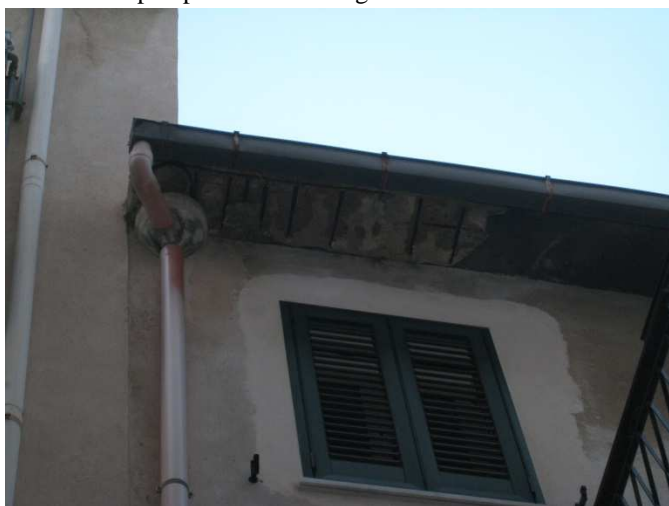
Foto n. 2. Dettaglio della pensilina.
