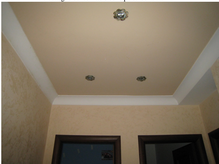
Foto n. 23 e 24. Il contro soffitto ed i gessi impiegati nel disimpegno del 2° piano.
