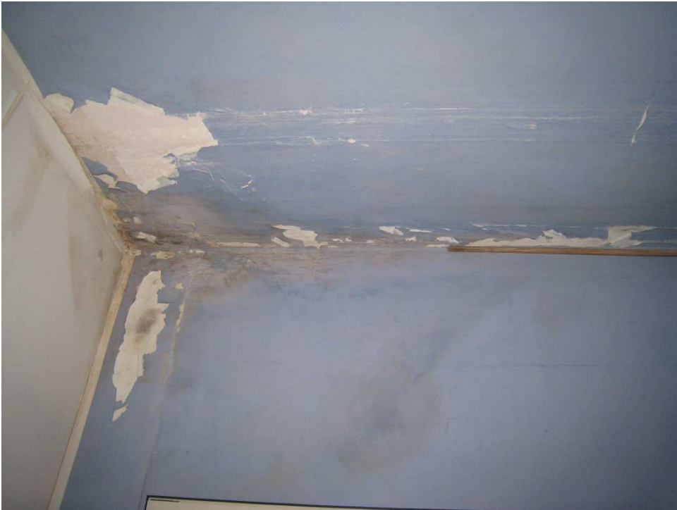
Foto n. 20 e 21. Le condizioni in cui versa il soffitto a seguito delle infiltrazioni provenienti dal tetto.
