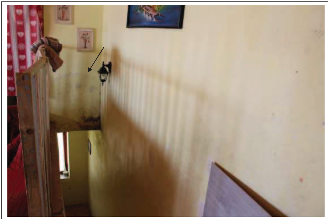
Foto n. 19 – Appartamento sito in Altofonte, Via Celso n. 1, piano 4°. Stato di fatto delle pareti prossime al corpo scala. Si nota la presenza di vistosi fenomeni umidi
