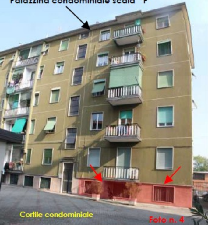
Palazzina condominiale scala "F"
