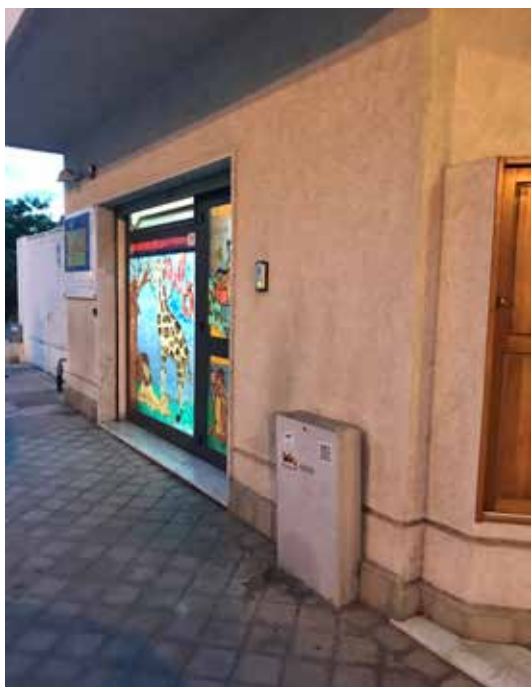
Foto 5. Ingresso alla scuola materna posto su prospetto principale.
