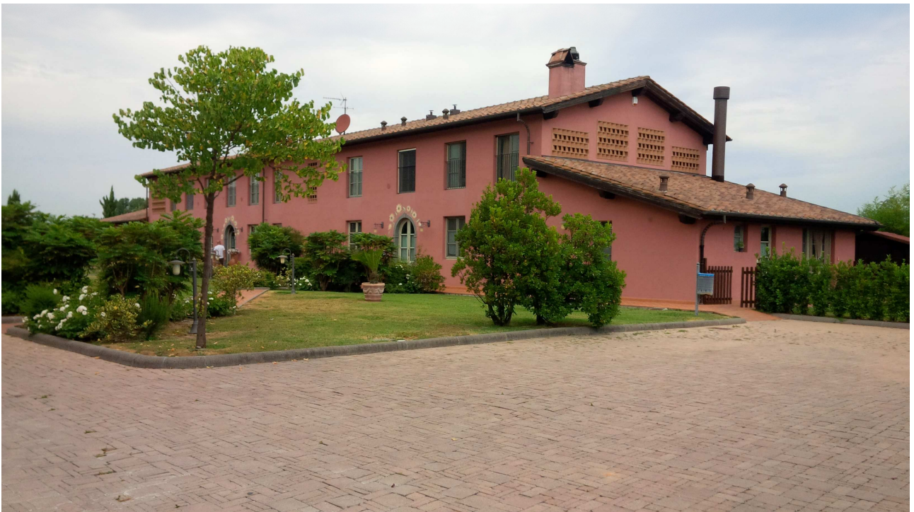
Vista lato sud est
