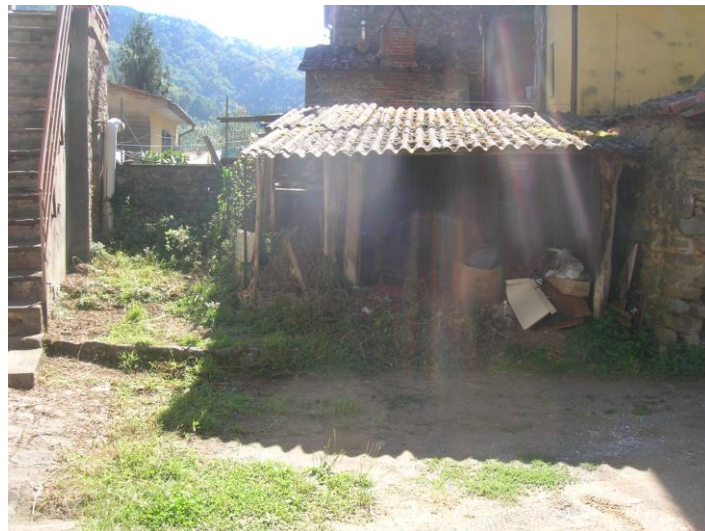
Resede esterna ( opere precarie da demolire )
